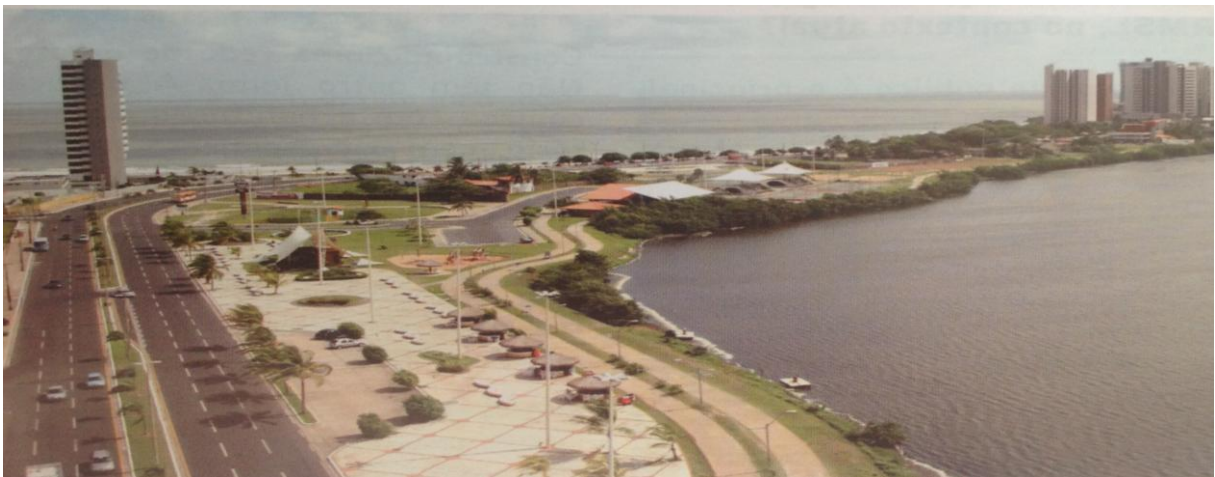
Figura 4 - Imagem da Laguna da Jansen depois das obras de beneficiamento
