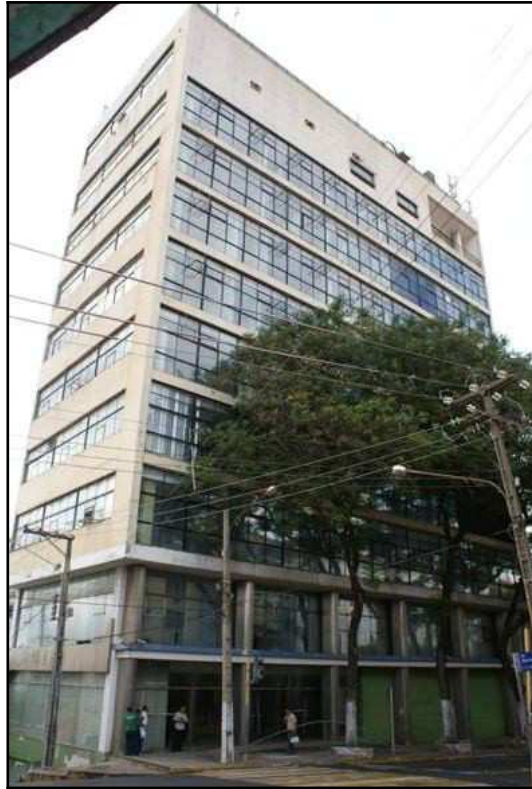
Figura 38 - Edifício do BEM, 2008.
