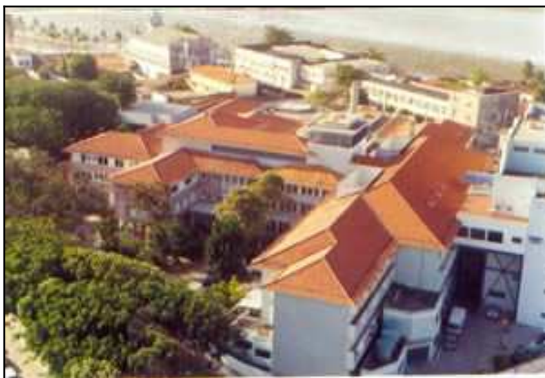
Figura 35 - Telhados do Hospital Presidente Dutra.
