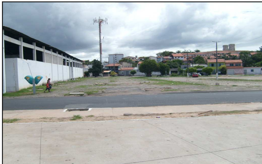
Figura 43 – Fachada lateral com vista para área destinada a estacionamento
