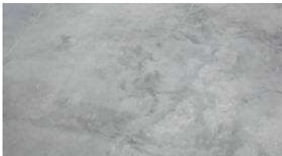
Figura 13 - Aspecto final do piso de cimento queimado Fonte: www.cimentoeareia.com.br
