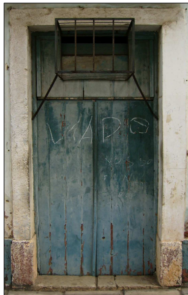
Fig. 62 – Esquadria 22 vista da Rua 14 de Julho. Fonte: Hilbert Brunno, 2006.
