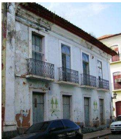
Fig. 04 – Fachada Principal Vista da Rua do Giz. Fonte: Hilbert Bruno, 2006.
