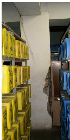
Fig. 14 – Viga e pilar de concreto armado entre as estantes de ferro. Fonte: Hilbert Brunno, 2006.
