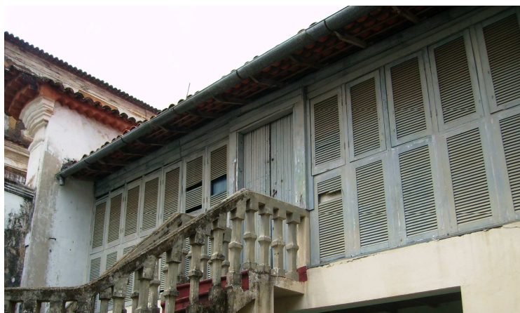
Fig. 13 – Parede de esquadrias no pavimento superior. Fonte : Hilbert Brunno, 2006.
