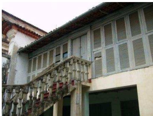
Fig. 05 – Fachada Posterior vista do pátio interno. Fonte: Hilbert Bruno, 2006.
