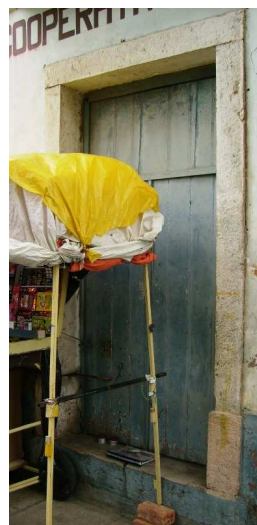
Fig. 50 – Esquadria 10 vista da Rua 14 de Julho. Fonte: Hilbert Brunno, 2006.
