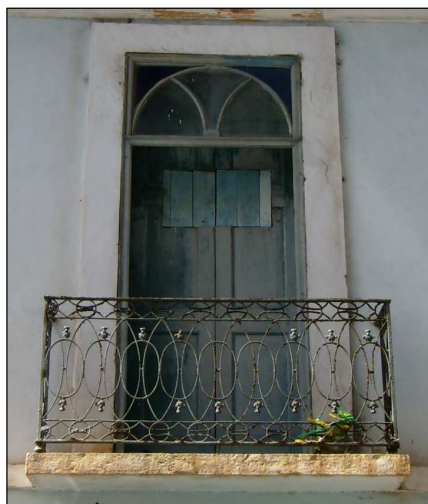
Fig. 51 – Esquadria 11 vista da Rua 14 de Julho. Fonte: Hilbert Brunno, 2006.
