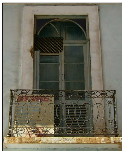
Fig. 55 – Esquadria 15 vista da Rua 14 de Julho. Fonte: Hilbert Brunno, 2006.
