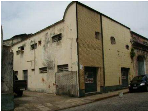
Fig. 67 – Vista do edifício nº. 99 aos fundos do lote 93 na Rua 14 de Julho. Fonte: Hilbert Brunno, 2006.
