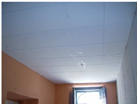
Fig. 38 – Forro de gesso no pavimento superior. Fonte: Hilbert Brunno, 2006.
