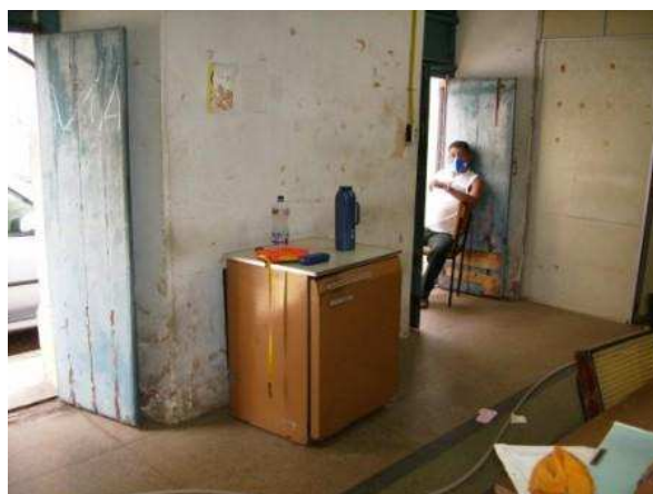
Fig. 25 - Sala de reparos e sala de refeições. Fonte: Hilbert Bruno, 2006.
