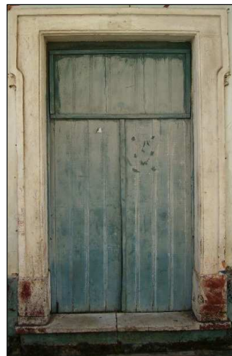
Fig. 54 – Esquadria 14 vista da Rua 14 de Julho. Fonte: Hilbert Brunno, 2006.
