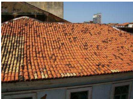
Fig. 40 – Vista da cobertura do Sobrado n°. 93. Fonte: Hilbert Bruno, 2006.
