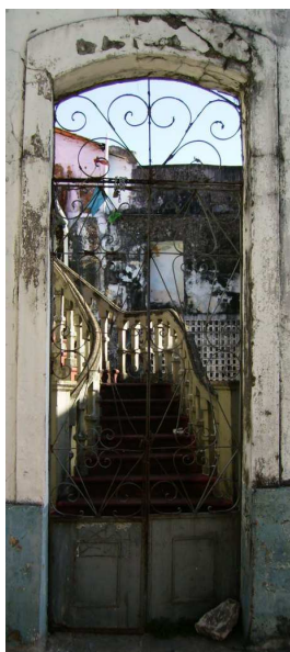
Fig. 18 – Portão de ferro lateral. Fonte: Hilbert Brunno. 2006.
