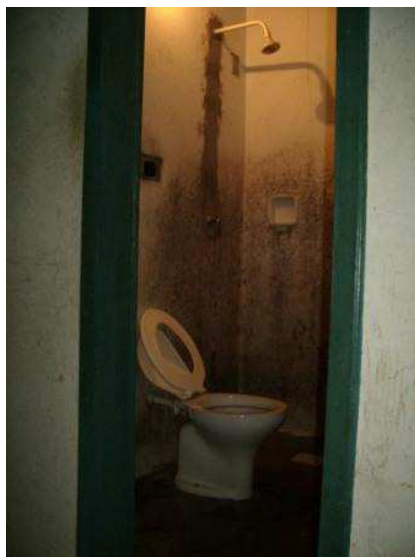
Fig. 22 – Banheiro de funcionários com chuveiro. Fonte: Hilbert Brunno, 2006.
