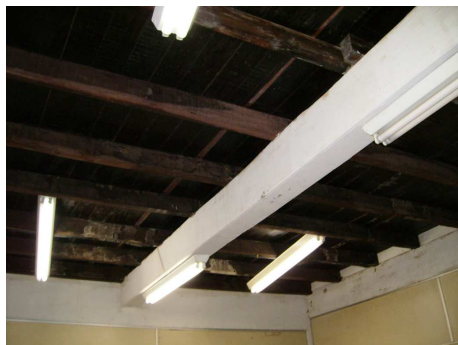
Fig. 08 – Barroteamento de madeira e piso de tábua corrida. Fonte: Hilbert Brunno, 2006.
