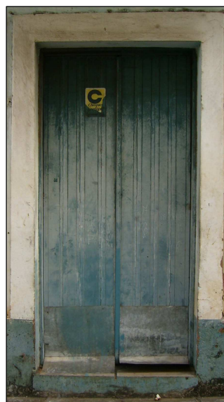
Fig. 58 – Esquadria 18 vista da Rua 14 de Julho. Fonte: Hilbert Brunno, 2006.
