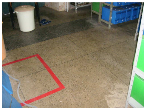
Fig. 34 – Piso Korodur no pavimento térreo. Fonte: Hilbert Bruno, 2006.
