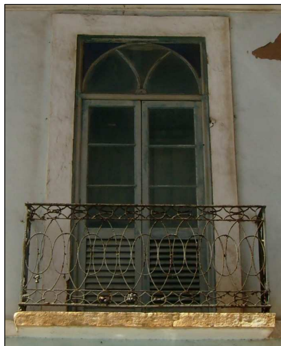
Fig. 53 – Esquadria 13 vista da Rua 14 de Julho. Fonte: Hilbert Brunno, 2006.
