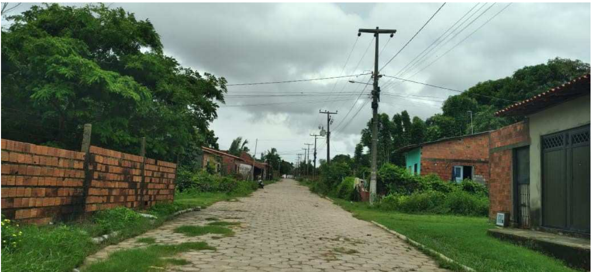
Figura 7 – Foto 4 da Avenida São José localizada no bairro Todos os Santos
