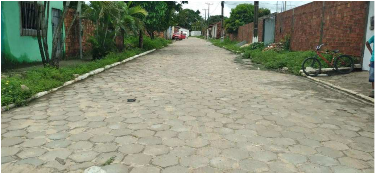
Figura 5 – Foto 2 da Avenida São José localizada no bairro Todos os Santos
