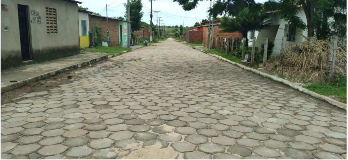
Figura 6 – Foto 3 da Avenida São José localizada no bairro Todos os Santos
