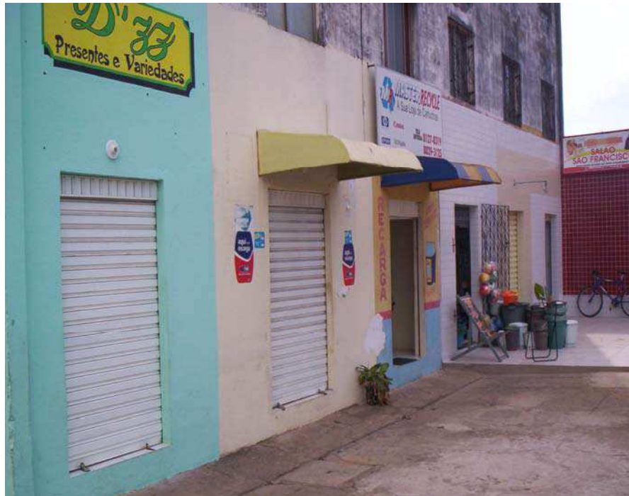
Figura 84– Conjunto de apartamentos no térreo transformados em ponto comercial Fonte: Acervo pessoal,2007.
