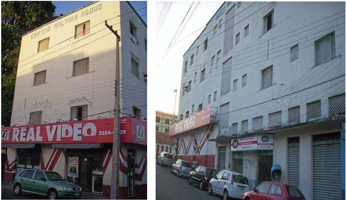
Figura 41 – Fachadas das Ruas do Passeio e Caminho da Boiada respectivamente nos dias atuais aonde observa-se lojas no térreo. Fonte: Acervo pessoal, 2007.
