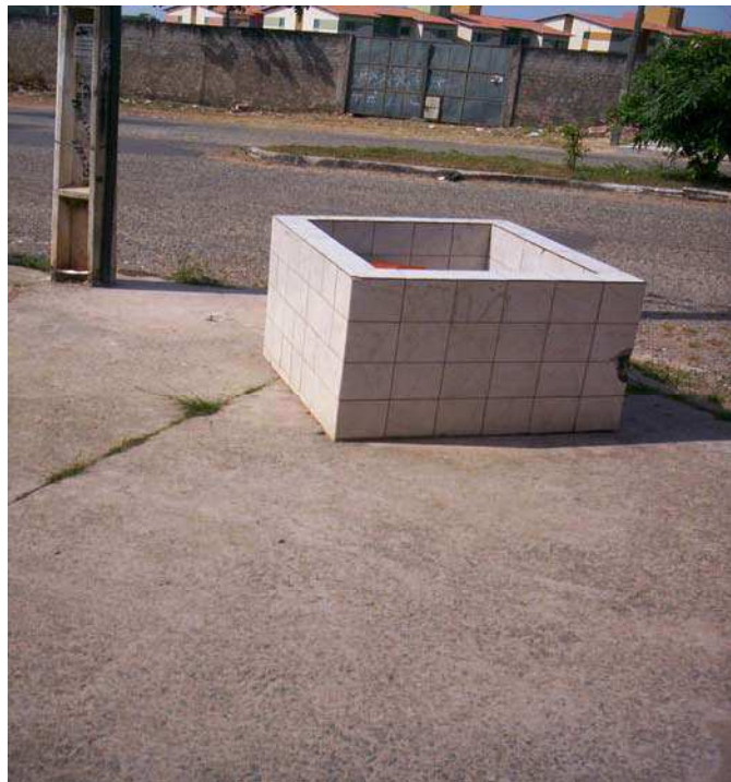
Figura 80 - Depósito de lixo inadequado Fonte: :Acervo pessoal,2007.
