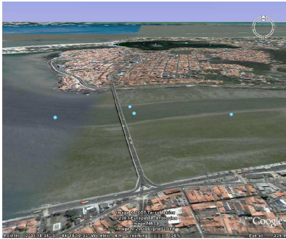
Figura 34 – Vista atual da ponte Gov. José Sarney Fonte: Google Earth
