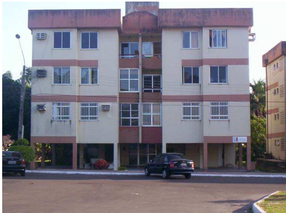
Figura 120 – Fachada principal dos blocos de apartamentos
