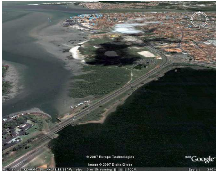
Figura 36 – Vista atual da barragem sobre o rio Bacanga Fonte: Google Earth
