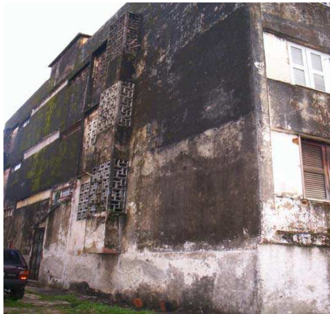
Figura 60 – Destaque nesta fachada para elementos vazados de concreto das áreas de serviço do bloco Fonte: Acervo pessoal, 2007..
