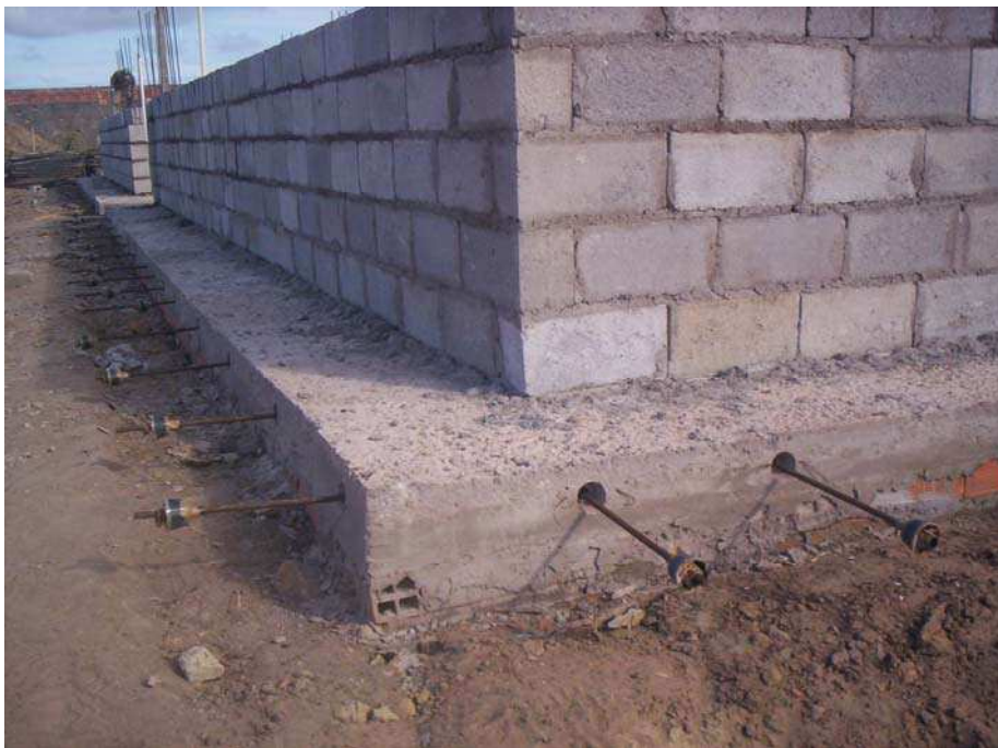
Figura 124 – Radier na fundação e alvenaria estrutural na vedação Fonte: Dimensão Engenharia, 2007.
