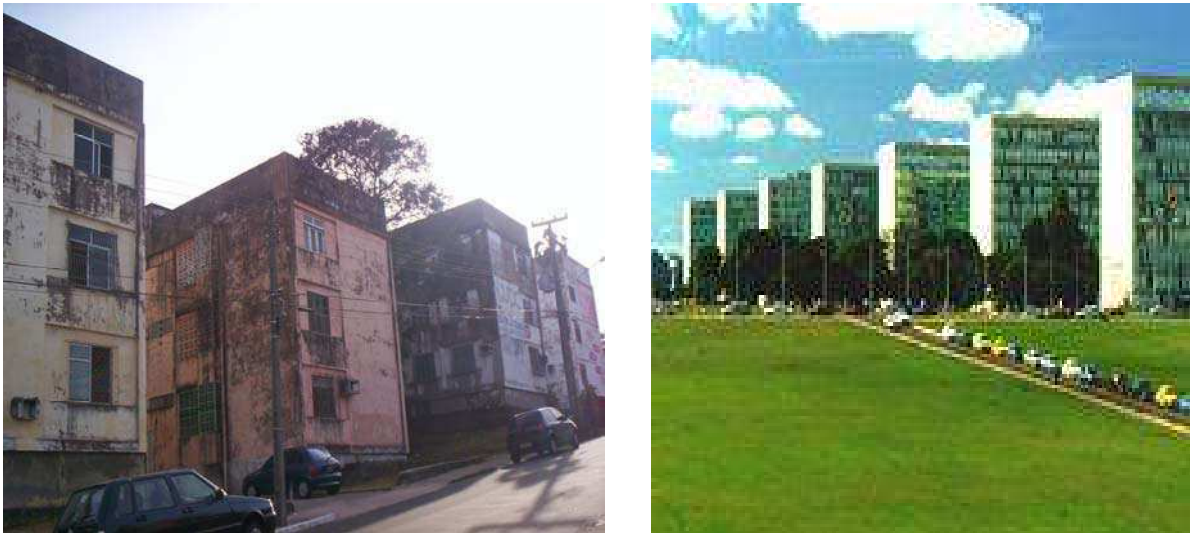
Figura 53 – Vista dos blocos residenciais do Conj. dos Bancários em forma laminar dispostos paralelamente entre si conforme partido adotado na concepção de Brasília Fonte: Acervo pessoal,2007.
