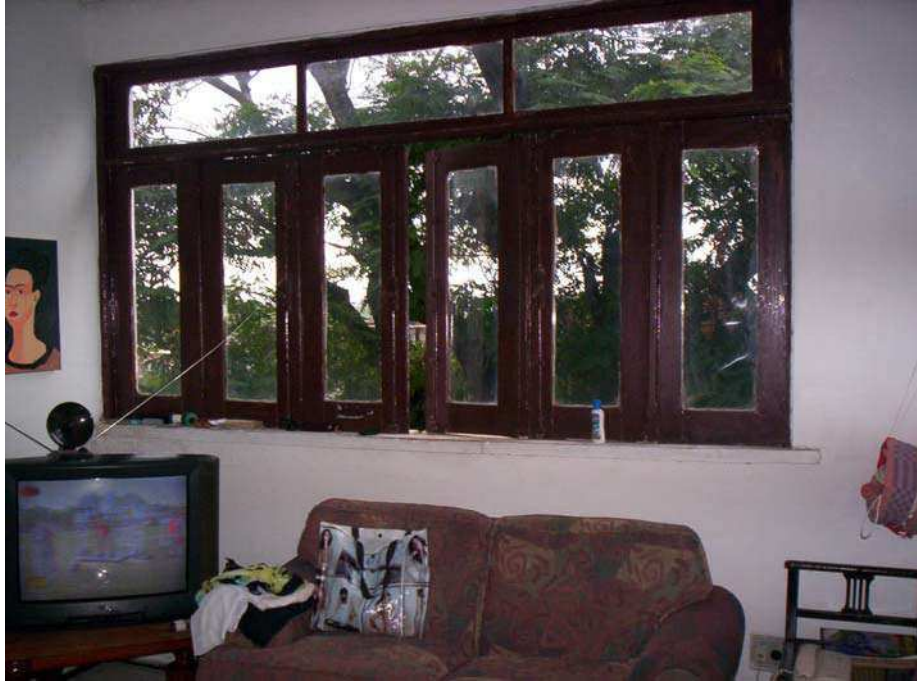
Figura 54 – Esquadria de madeira originária da época de construção Fonte: Vasconcelos 2007
