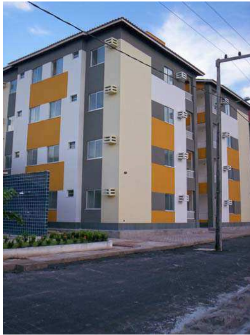
Figura 146 – Vista das fachadas frontal e lateral Fonte: Acervo pessoal, 2007.
