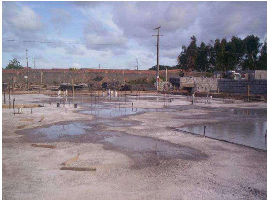
Figura 140 – Radier como fundação e sendo preparado para receber a alvenaria de blocos estruturais de concreto
