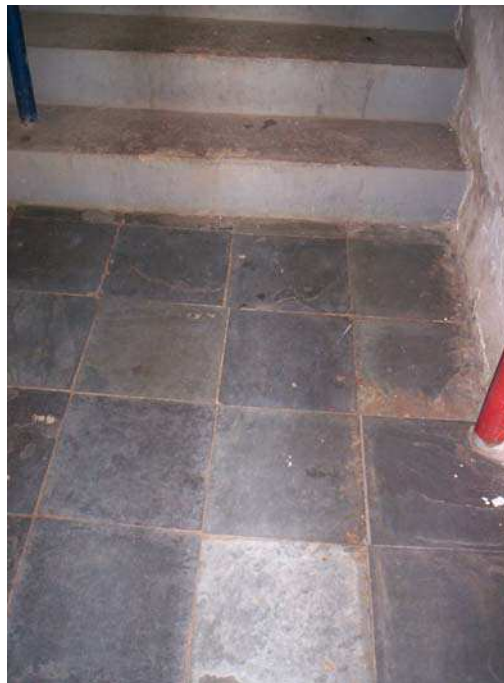
Figura 111 – piso ardósia de área comum em bom estado de conservação Fonte: Acervo pessoal, 2007.
