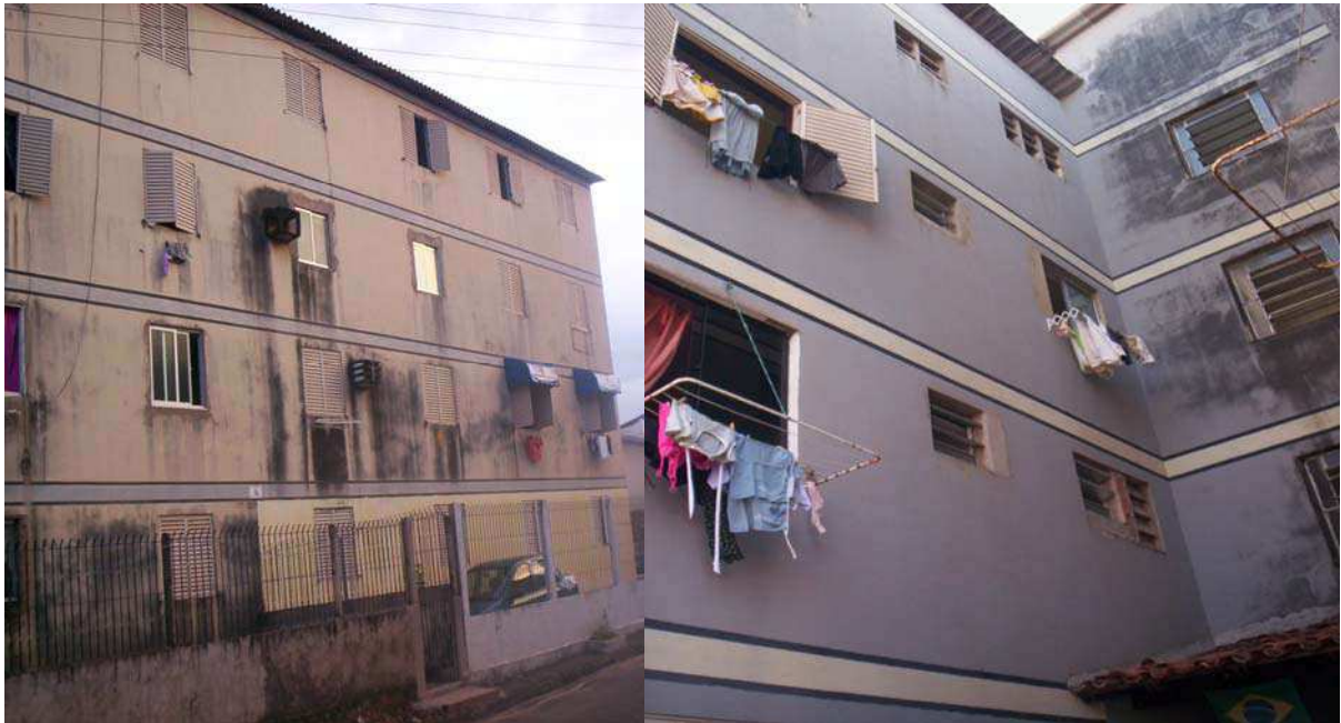
Figura 92 – Fachada dos blocos vendo-se diversos materiais nas esquadrias elementos externos como toldos e roupas
