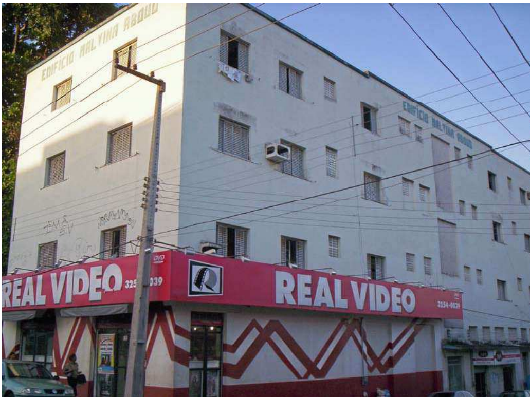
Figura 50 – Vista das fachadas principal e secundária Fonte: Acervo pessoal, 2007.
