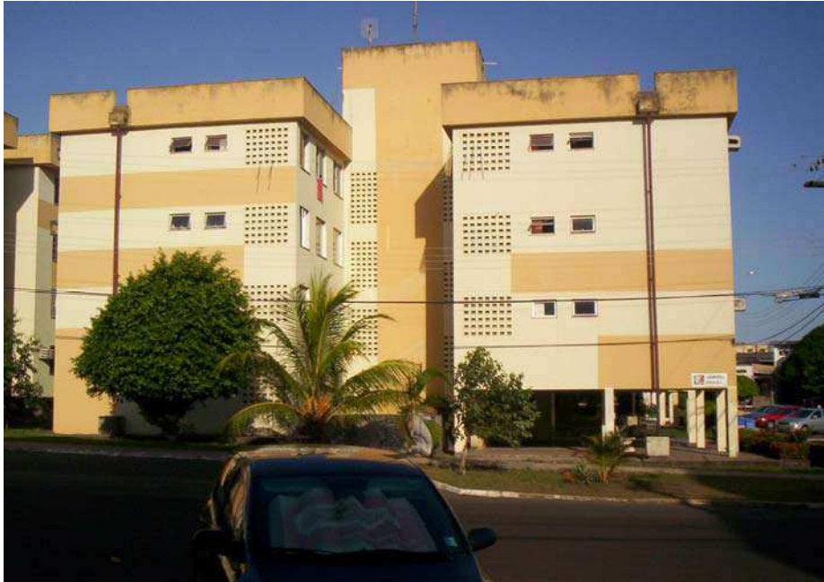
Figura 121 – Fachada secundária apresentando elementos vazados ajudando a compor a fachada Fonte: Acervo pessoal, 2007.
