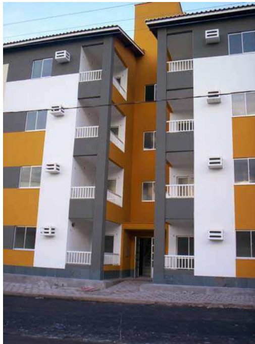
Figura 147 – Vista da fachada frontal observando-se a integração de elementos como caixa de ar condicionado e gradil na varanda Fonte: Acervo pessoal, 2007.
