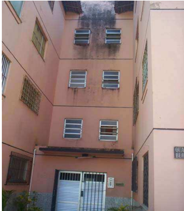
Figura 96 – Esquadrias de alumínio, características da época de construção, mantém-se em bom estado Fonte: Acervo pessoal, 2007
