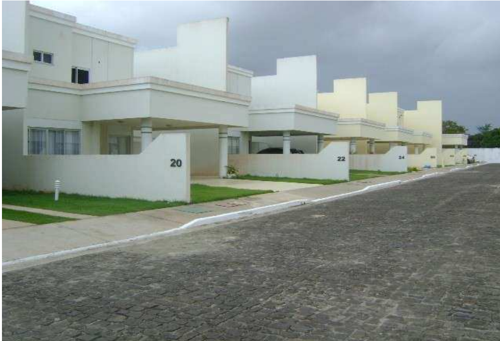
Figura 20: A cada três unidades residenciais pintura na cor cinza e na seqüência pintura na cor marfim (Condomínio Enseada do Atlântico)
