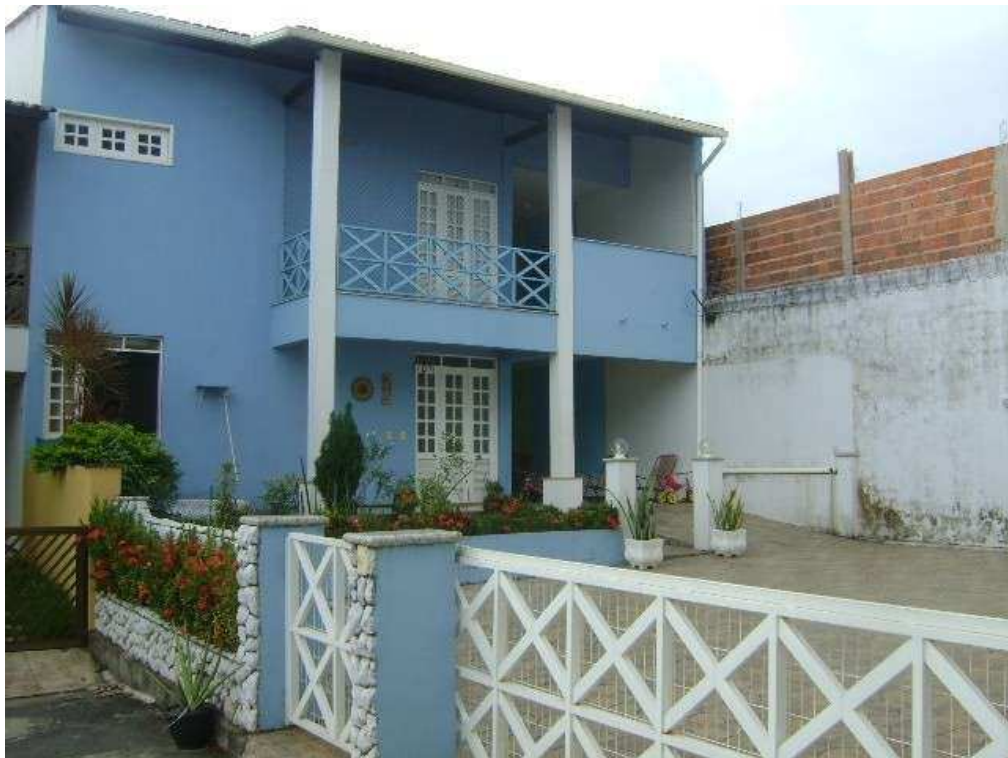
Figura 37: O azul claro como cor predominante na fachada com detalhes em branco(Condomínio Village Du Soleil) Fonte: Arquivo pessoal
