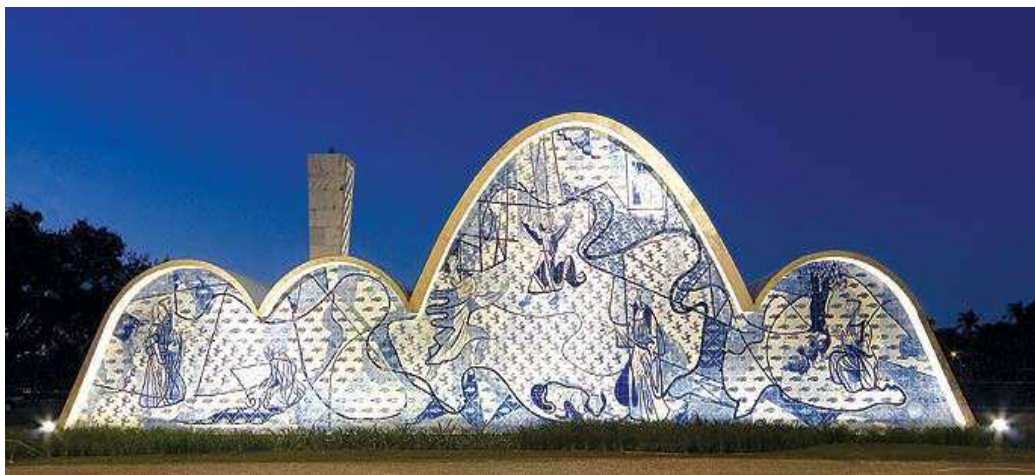
Figura 08: Igreja da Pampulha – Belo Horizonte
