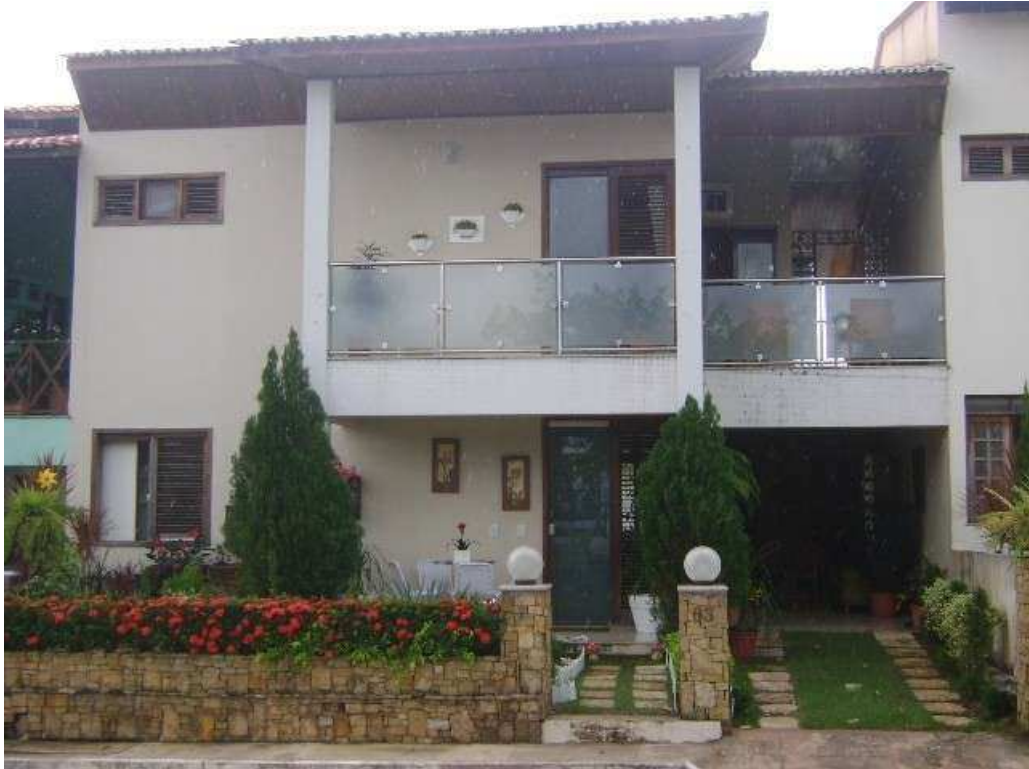
Figura 38: Um tom de bege como cor predominante na fachada, com detalhes em pedra, revestimento em pastilhas branca e blindex na sacada.
