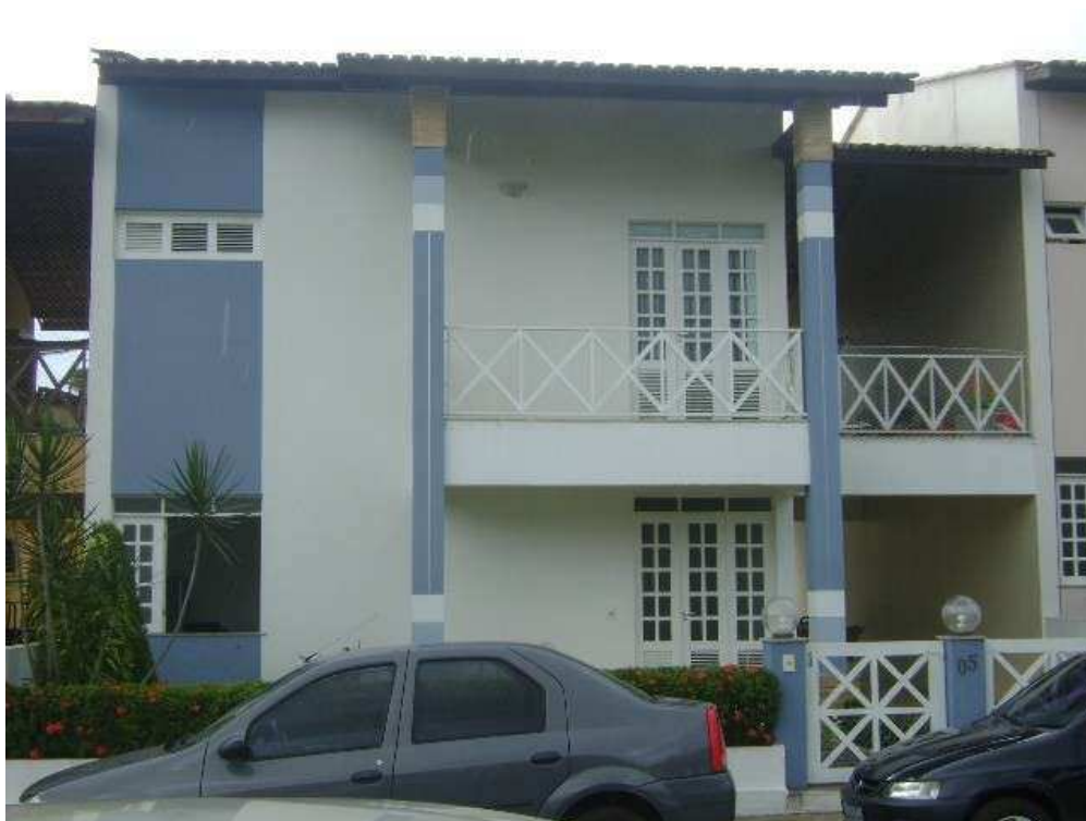
Figura 41: O branco como cor predominante na fachada com detalhes em azul
