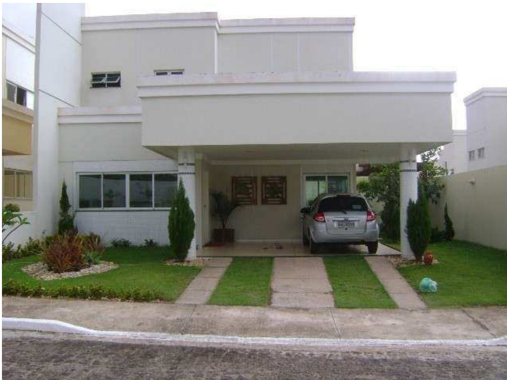
Figura 25: Fachada na cor cinza com detalhes em branco(Condomínio Enseada do Atlântico) Fonte: Arquivo pessoal
