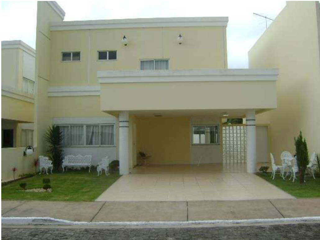
Figura 24: Fachada na cor marfim com detalhes em branco(Condomínio Enseada do Atlântico) Fonte: Arquivo pessoal
