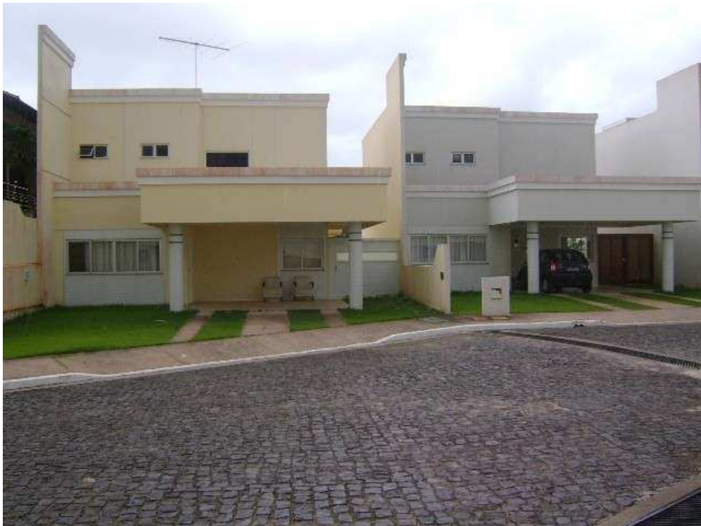
Figura 23: Vista frontal das unidades residenciais, telhado com platibanda, forma arquitetônica retangular (Condomínio Enseada do Atlântico)
