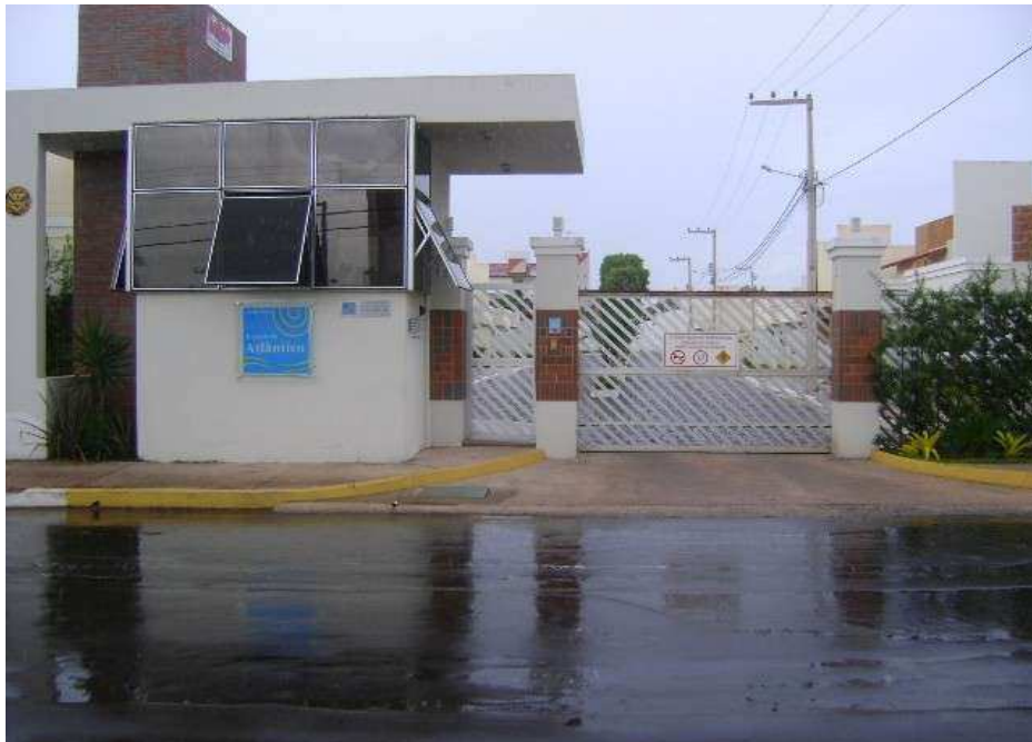
Figura 19: Acesso principal do Condomínio Enseada do Atlântico
