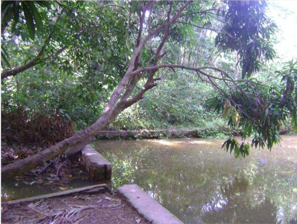
Foto 1 – Foto da barragem de irrigação do Itapiracó. Fonte: Autora.
