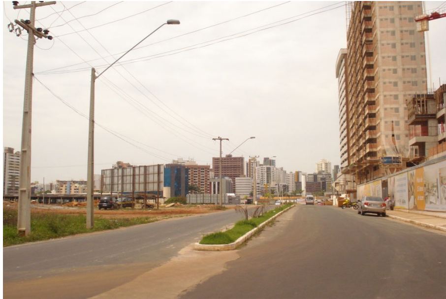
Figura 17. Av. das Monções: prédios residenciais em construção Fonte: a autora
