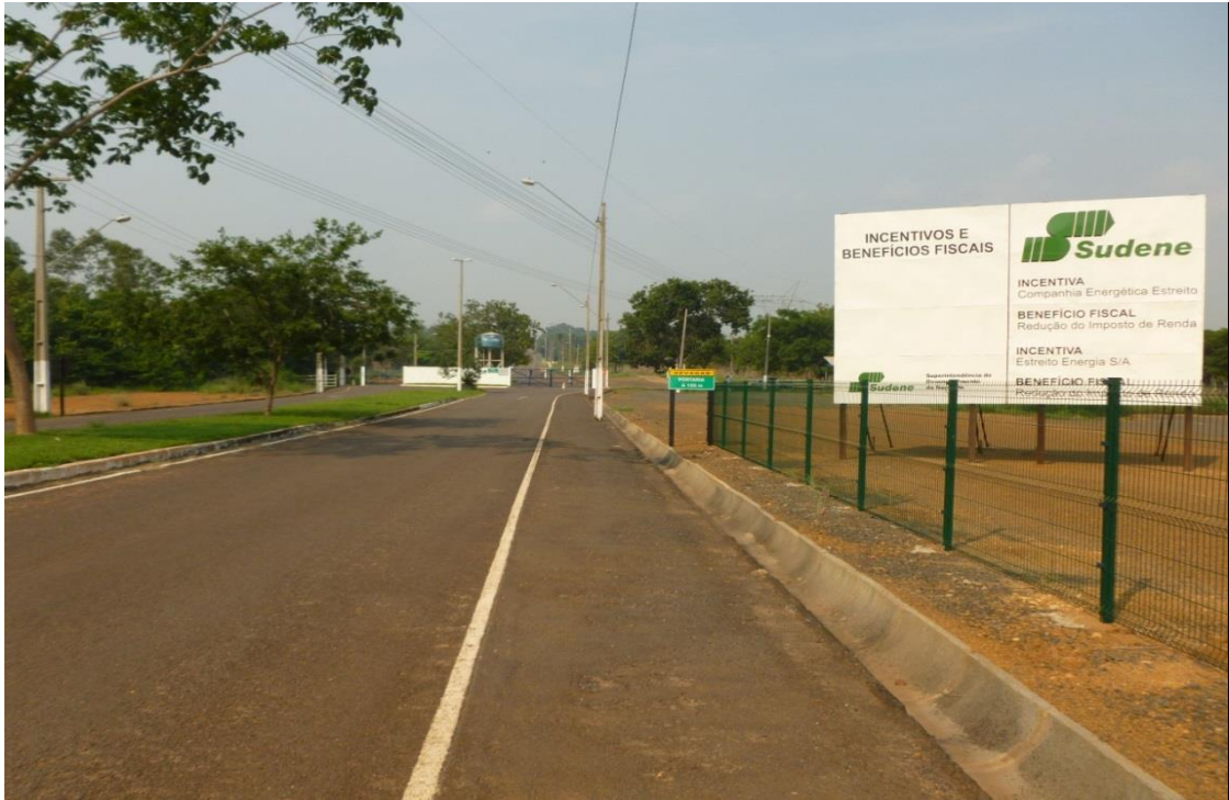
FIGURA 8: Entrada da UHE-Estreiro na cidade de Estreiro, acesso pela rodovia BR 230, Transamazônica.
