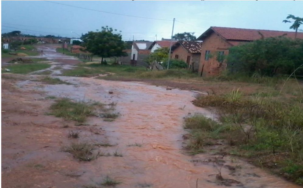
FIGURA 17: A: Bairro Ticoncá com problemas de drenagem e ruas sem pavimentação.
