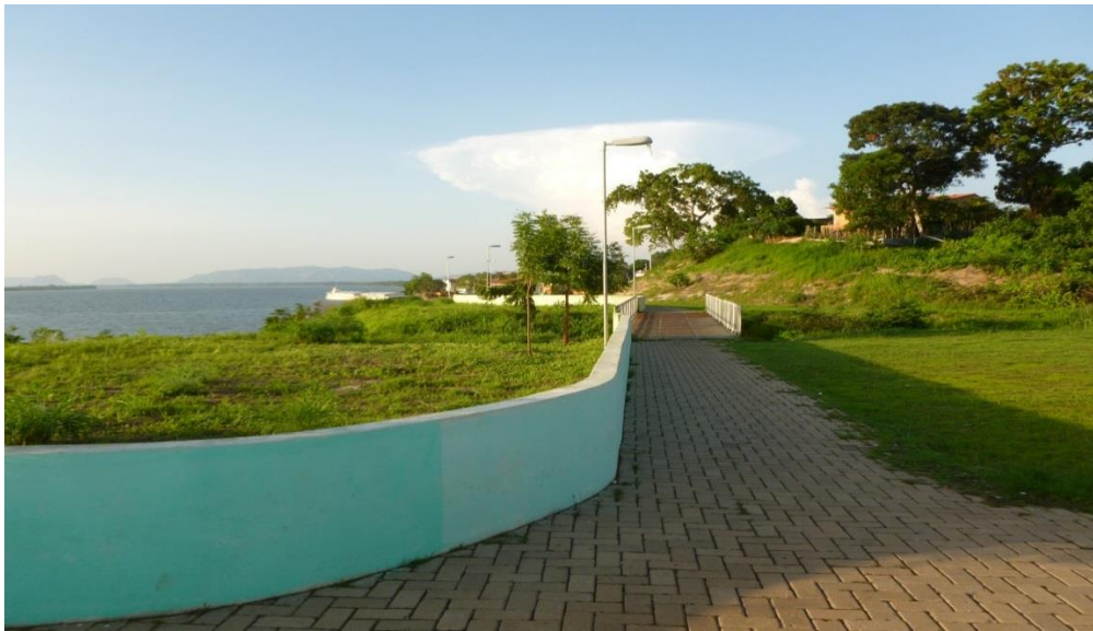
FIGURA 24: Obras de recomposição feitas pelo CESTE: Nova orla da beira-rio de Carolina.
