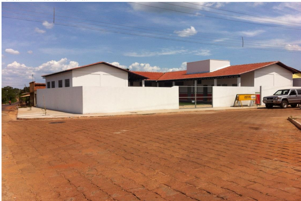
FIGURA 27: Obras de Compensação no município de Carolina: Escola de ensino básico no bairro Alto da Colina.
