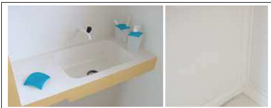
Figura 16 – Bancada com cuba e canto formado pelo piso e duas paredes com as canaletas.
