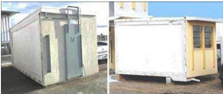
Figura 3 – Módulos de cela típicos, exibindo as faces laterais, porta de acesso e janelas Fonte: Relatório de Análises do Sistema Construtivo Penitenciário / Avaliação Técnica e da Relação Custo Benefício, p. 27.
