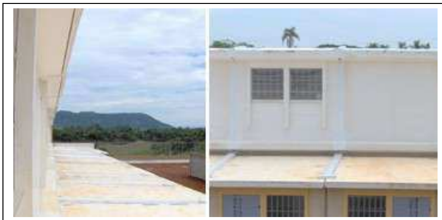
Figura 21 – Coberturas sobre os módulos de celas: trânsito para manutenção e vistorias.
