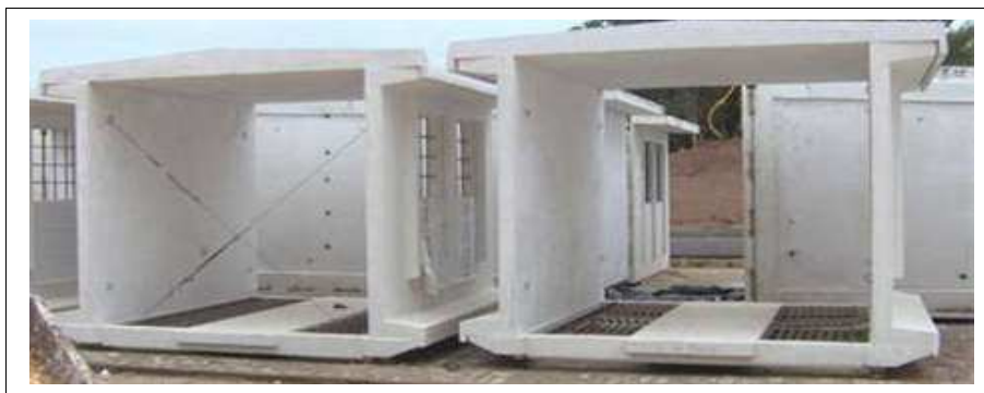
Figura 11 – Módulos de passarela montados no pátio da fábrica (ULBRA).
