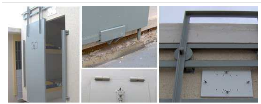
Figura 18 – Detalhe da porta dos módulos.
