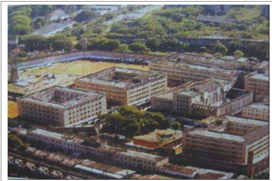
Figura 1 – Casa de Detenção do Estado de São Paulo / Carandiru.
