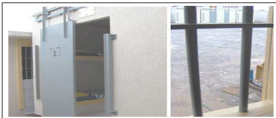
Figura 14 – Porta do módulo de cela chumbada já na concretagem.
