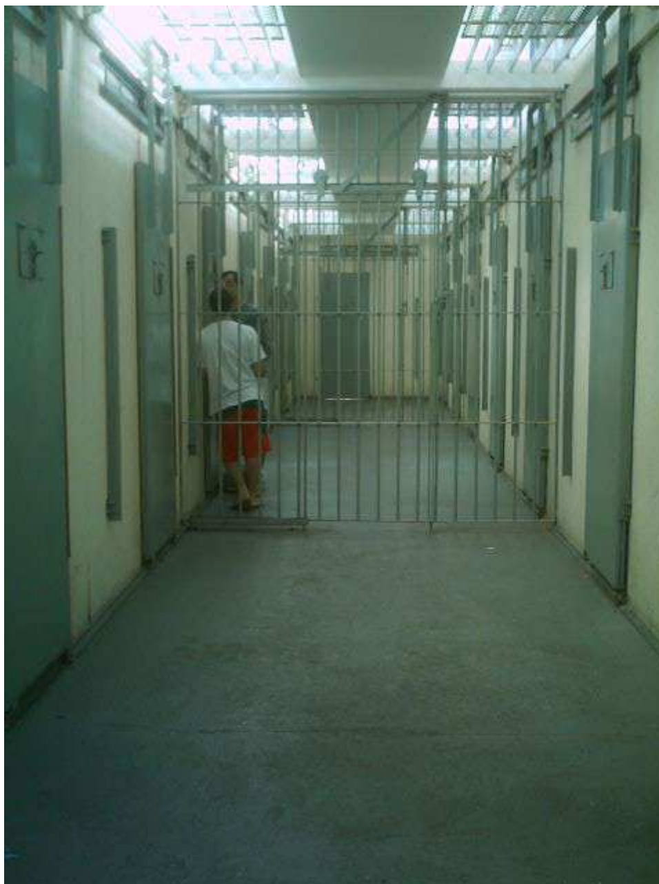
Figura 31 – Corredor de acesso as celas do Centro de Detenção Provisória.
