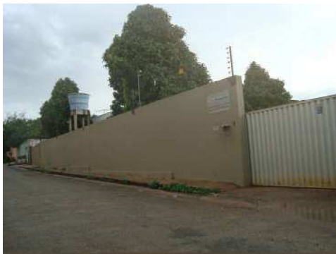
Figura 10 - Empresa de tratamento de lixo hospitalar no bairro Calhau
