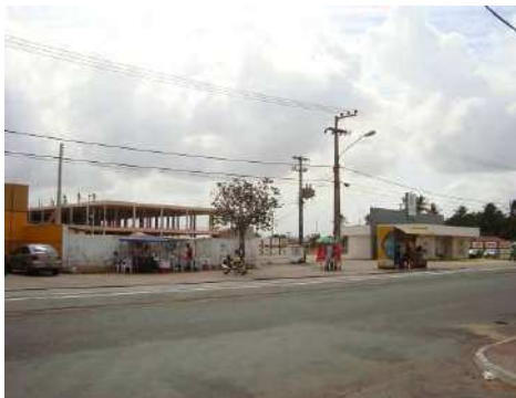
Figura 5 - Construção de shopping no bairro do Turu
