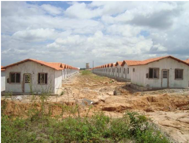
Figura 31 - Habitação unifamiliar - Residencial Turiuba
