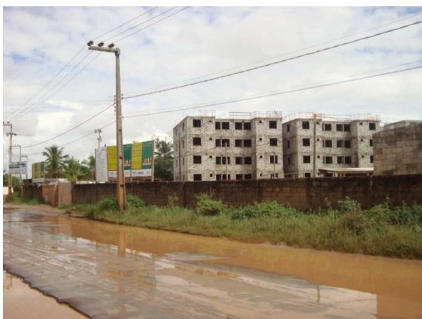
Figura 2 – Via de acesso ao Residencial São José de Ribamar
