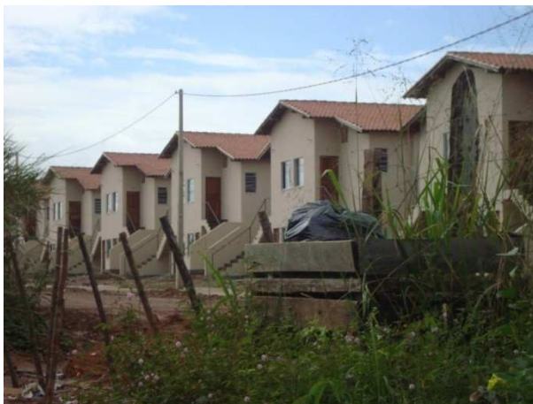
Figura 10 - Habitação multifamiliar duplex - Residencial Nova Aurora
