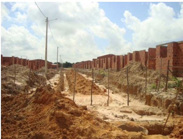
Figura 6 - Instalação de caixas de visita para rede de esgoto no Residencial Nova Esperança
