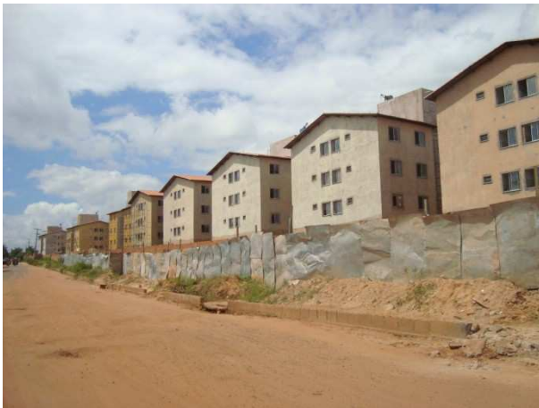
Figura 26 - Habitação Multifamiliar - Residencial São José
