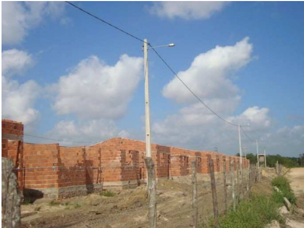
Figura 7 - Instalação de iluminação pública no interior do Residencial Nova Esperança
