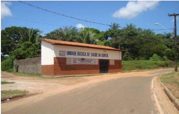
Figura 18 - Estrada da Quinta - acesso ao Residencial Nova Terra
