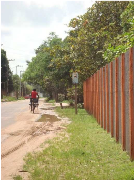
Figura 3 - Sinalização de ponto de ônibus próxima ao Residencial São José de Ribamar
