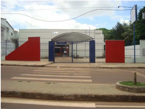
Figura 30 - Escola de ensino fundamental e médio - próxima ao Residencial São José
