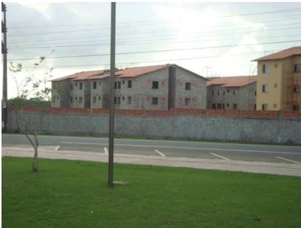
Figura 23 - Habitação multifamiliar - Residencial Pitangueiras
