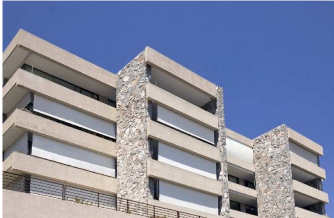
Figura 13 – Toldos Verticais em fachada de edifício
