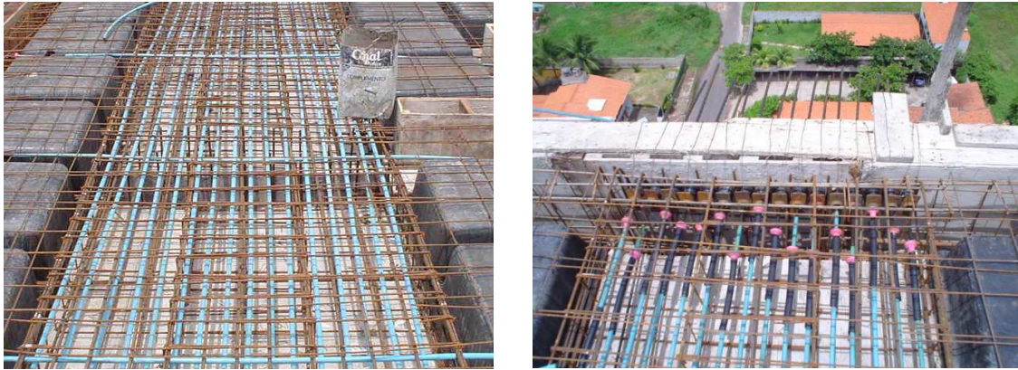
Figura 07 - Faixas protendidas em lajes nervuradas
