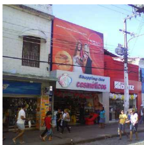
Placa publicitária impede identificação do prédio
