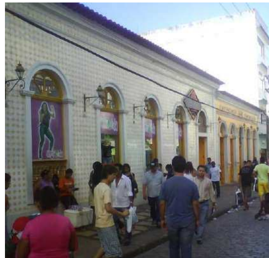
Imagem 13 – Fachada da Rua Grande
