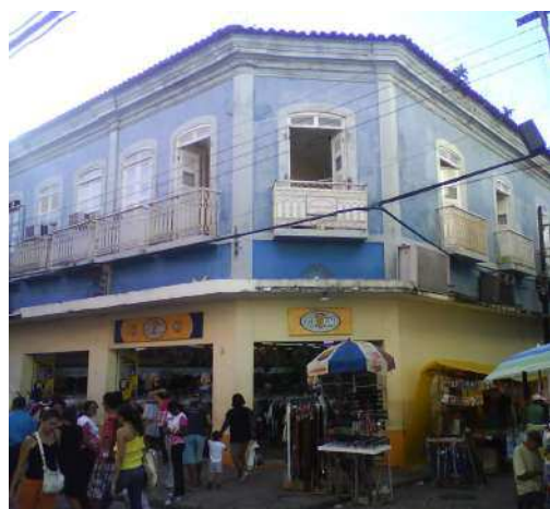
Fachada com maiores alterações no térreo
