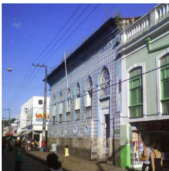
Imagem 06 – Fachada Rua Grande
