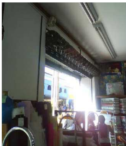
Porta de ferro colocada por dentro do vão
