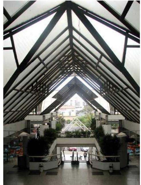
**Figura 42:** Detalhe da cobertura em estrutura metálica do Monumental.
