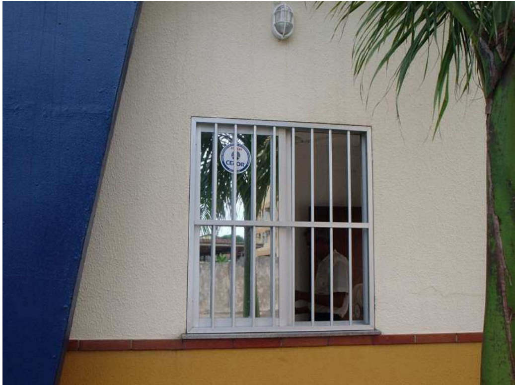
Foto 5: Guarita de identificação de visitantes. Fonte: Arquivo pessoal
