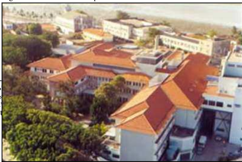
Figura 30 - Telhados do Hospital Presidente Dutra.
