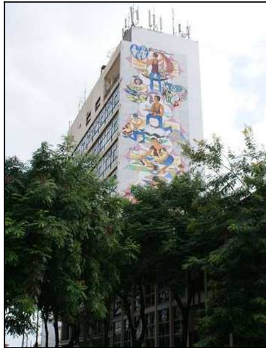
Figura 42 – Painel de Azulejos do edifício do BEM.
