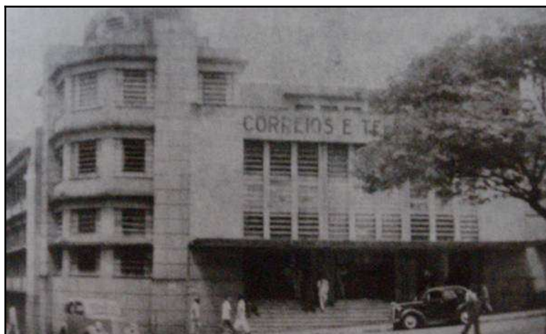
Figura 19 – Prédio dos Correios e Telégrafos.
