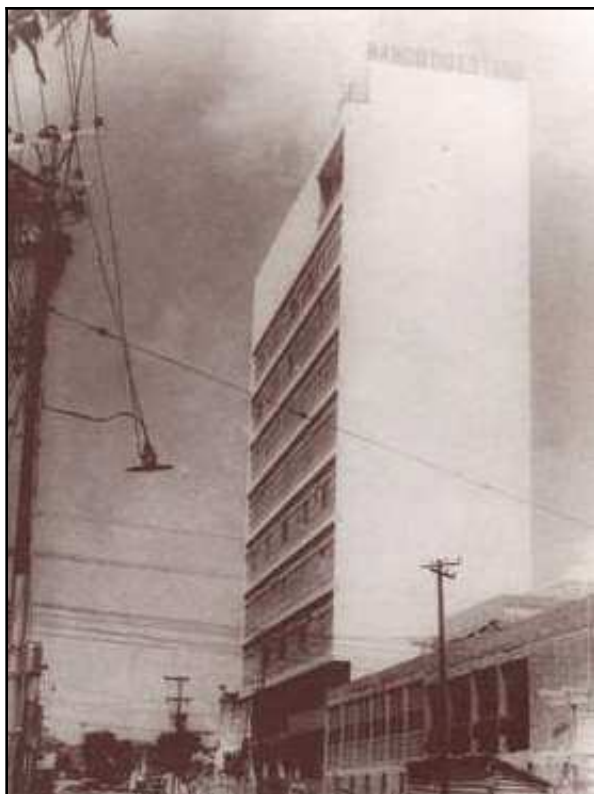
Figura 40 – Foto antiga do Edifício do BEM.
