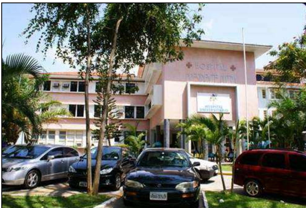
Figura 31 – Vista frontal do Hospital Presidente Dutra.
