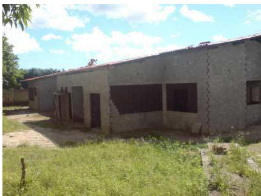
Figura 17 – Foto do Socorrinho em construção.
