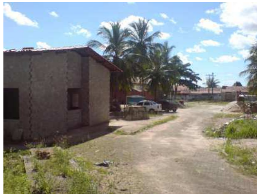
Figura 18 – Foto do Socorrinho em construção
