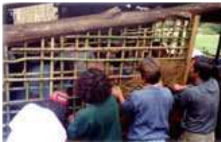
Fig. 17 Malha para pau-a-pique Disponível em: www.ecotecnica.com.br
