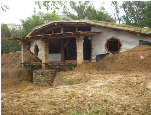
Fig. 11 Casa construída em solo compactado Fonte: Abib, 2006
