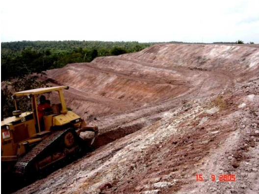
Fig. 38 Bota Fora do Alto, área B(banquetas) Fonte: Seibel, 2005
