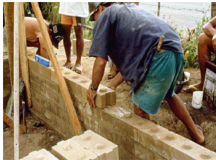
Fig. 33 Erguendo paredes Disponível em: www.jd.arq.br/construcoes
