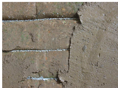
Fig. 14 Detalhe parede de adobe Fonte: Abib, 2006
