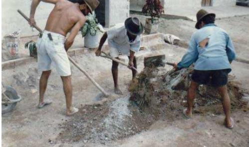
Fig. 31: Preparando a massa Disponível em: www.jd.arq.br/construcoes
