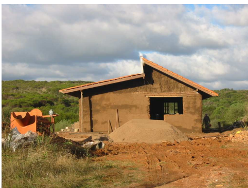
Fig. 13 Casa construída em adobe Fonte: Abib, 2006
