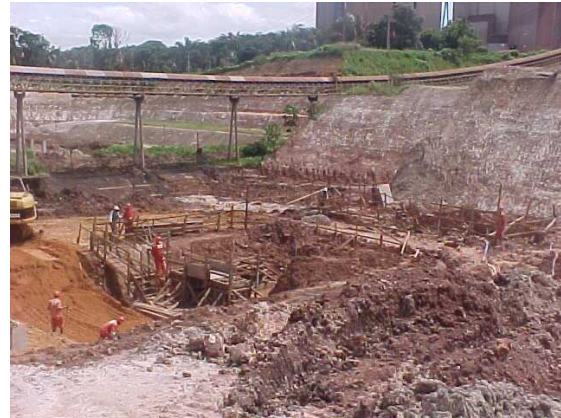
Fig. 37 Escavação para bases civis Fonte: Nogueira, 2005
