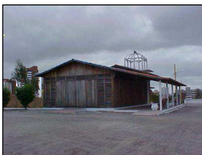
Figura 41: Fachada noroeste Fonte: Levantamento fotográfico – Autora
