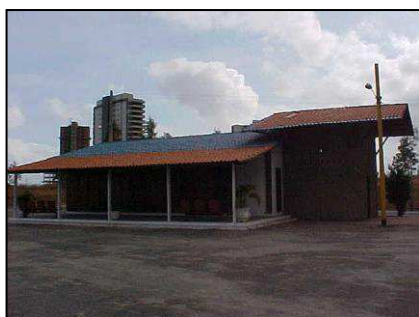
Figura 40: Fachada sudoeste Fonte: Levantamento fotográfico – Autora
