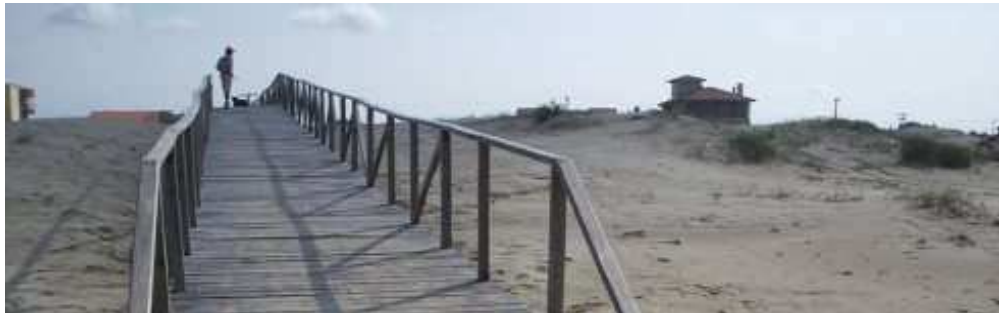
Figura 20 - Passarela construída na Praia do Cassino – RS
