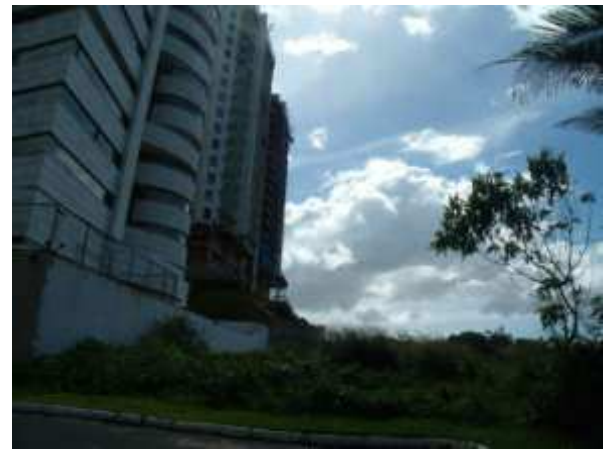
Figura 8: Prédio construído sobre dunas
