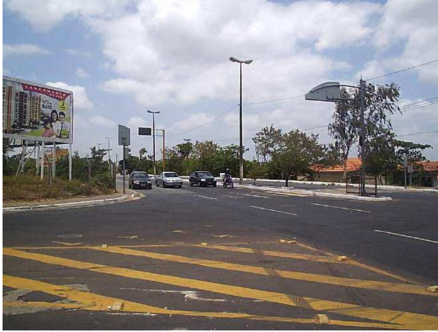
Figura 05 – Acesso lateral do terreno
