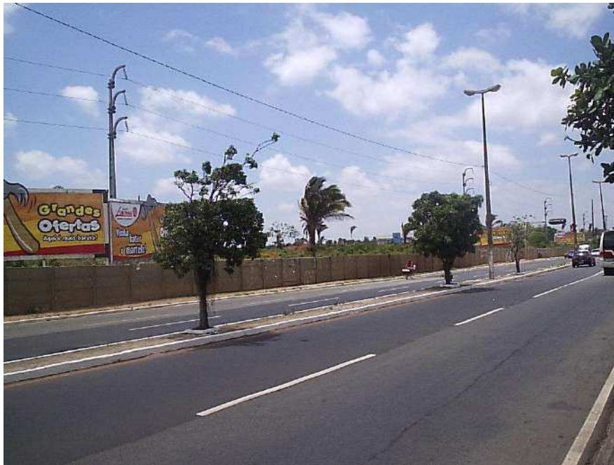
Figura 06 – Vista principal do terreno (sentido Vinhais)
