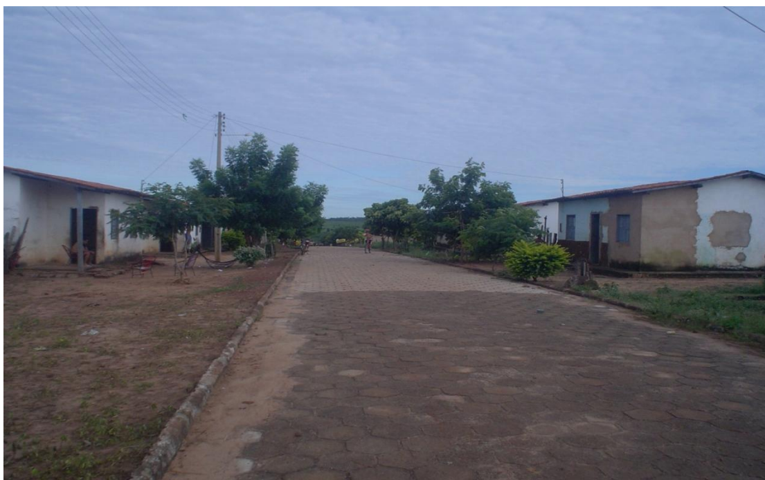
Figura 8 - Rua pavimentada e meio fio no assentamento
