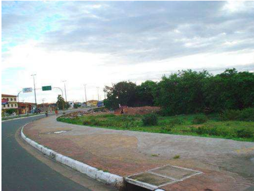
Figura 32 –Início da Av. Ferreira Gullar mostrando lixo e vegetação descaracterizada Fonte: Próprio autor
