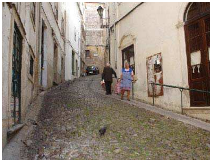
Figura 7.1. Corrimãos e piso aderente na Rua do Cabido, Coimbra. Fonte: Revista Infohabitar, 2006.
