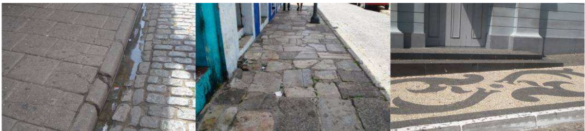
Figura 6.8. Principais calçamentos dos passeios no Centro Histórico de São Luís: blocos de concreto, pedra lioz e pedra portuguesa. Fonte: A Autora, 2010.
