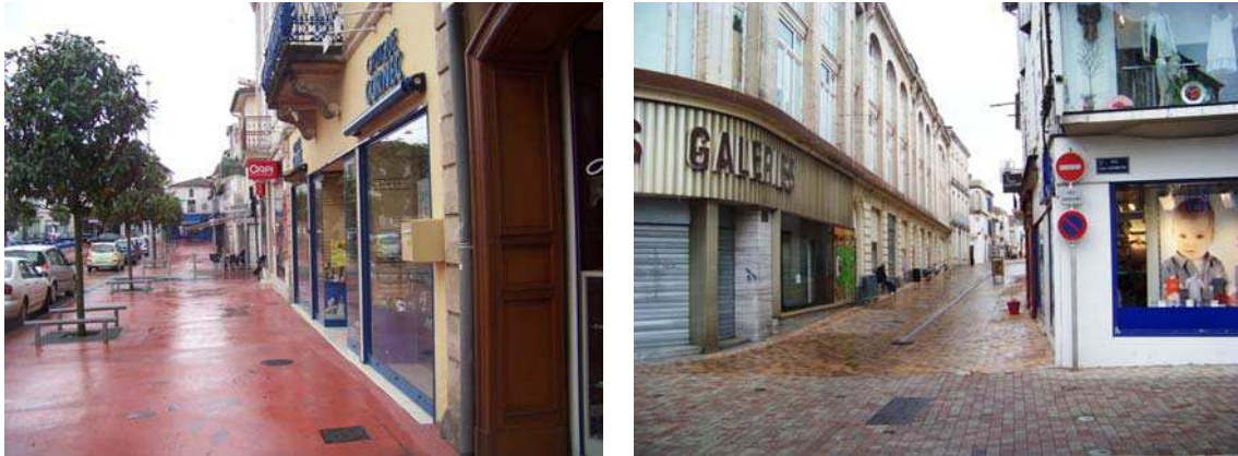
Figura 6.26. Calçada em concreto e via com drenagem no seu eixo tal como a proposta para a Rua Grande. Entorno da Praça Vermelha em Mont-de-Marsan, França. Fonte: A Autora, 2010.
