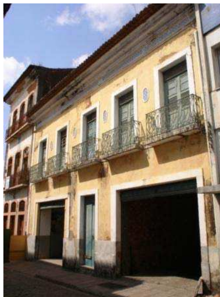
Figura 6.11. Imóvel na Rua da Palma cuja configuração original de vãos foi alterada a partir de reforma para criação de garagens. Fonte: IPHAN, 2008.
