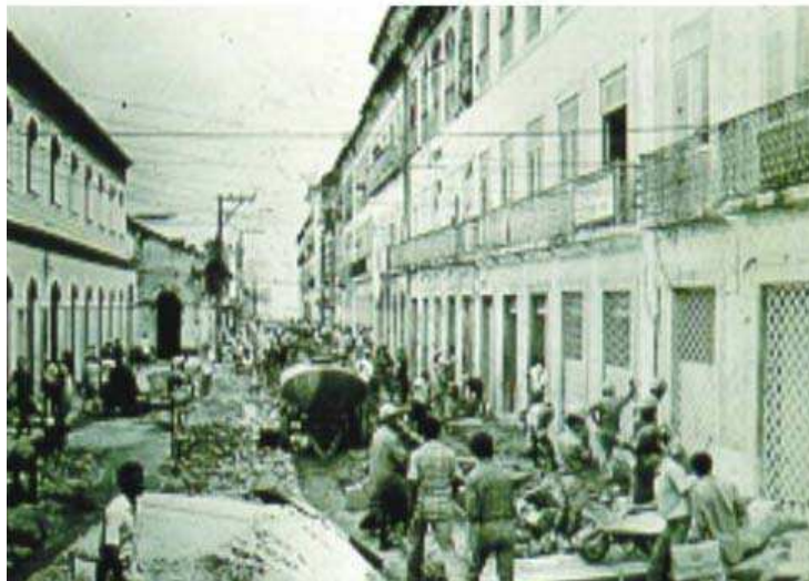
Figura 4.9. Rua Portugal durante as obras de revitalização do Projeto Reviver. Fonte: ANDRÈS,1997.
