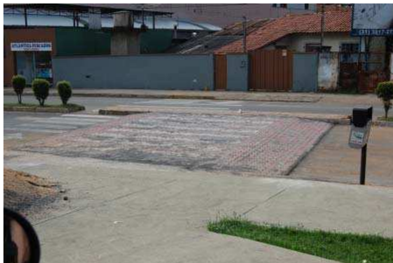
Figura 3.8. Faixa elevada, a mais adequada para travessia de pedestres. Fonte: http://bocaonopulpito.wordpress.com
