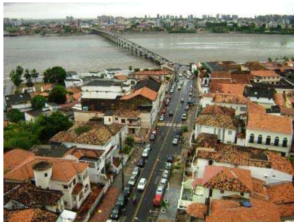
Figura 6.17. Rua do Egito em um dos trechos de projeto da ciclovia. Fonte: IPHAN, 2010.
