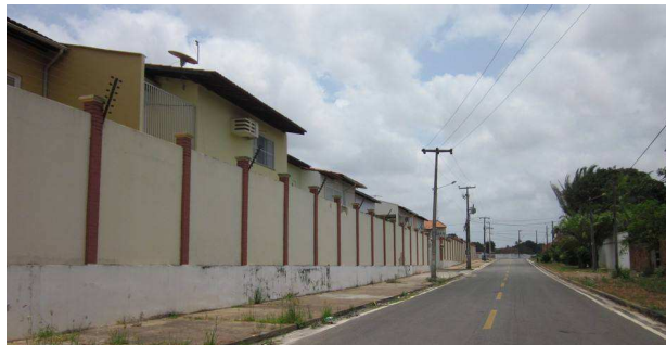
Figura 25 – Fachada do Condomínio 14
