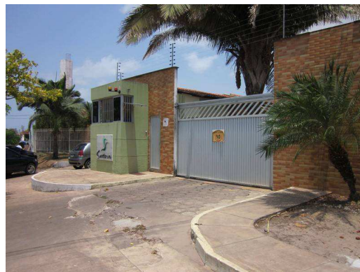
Figura 21– Fachada do Condomínio 27
