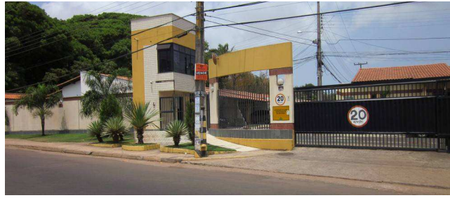
Figura 15 – Fachada do Condomínio 35 – Avenida Boa Esperança Fonte: Ricardo Cordeiro
