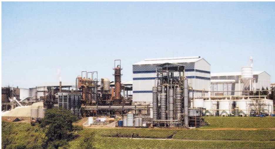
Figura 7 – Usina de Bioenergia Fonte: www.paraisobioenergia.com.br
