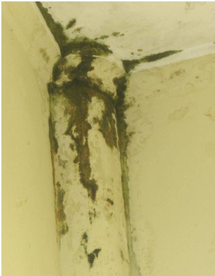
FOTO 44 – Detalhe da infiltração no forro
