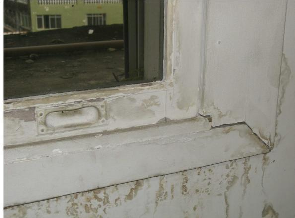
FOTO 53 – Detalhe da infiltração
