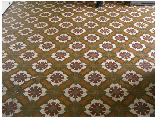
Fig. 14 – Piso em ladrilho hidráulico colorido
