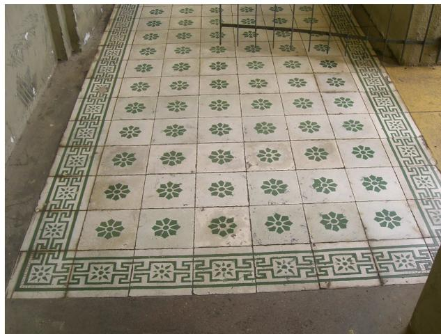
Fig. 15 – Piso em ladrilho hidráulico colorido
