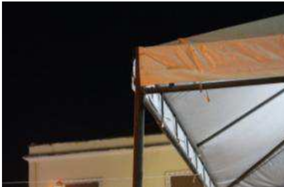
Figura 63 - Detalhe da estrutura da tenda utilizada na 10ª FeliS.
