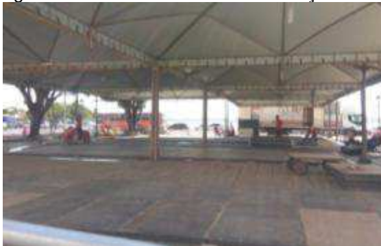
Figura 66 - Montagem da estrutura de madeira na Praça da Casa do Maranhão.
