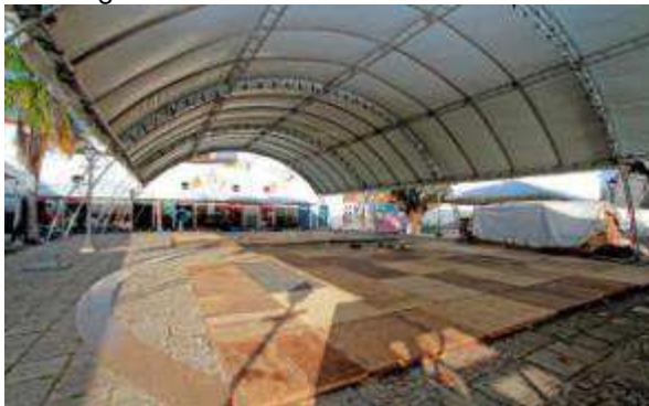
Figura 44 - Montagem da estrutura efêmera no bairro da Praia Grande.
