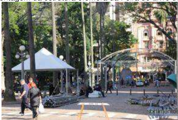
Figura 25 - Montagem da estrutura efêmera da Feira do Livro de Porto Alegre.
