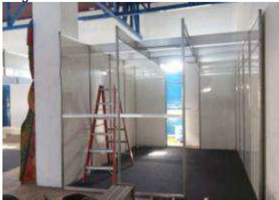
Figura 67 - Montagem dos stands na 10ª FeliS dentro da Casa do Maranhão.
