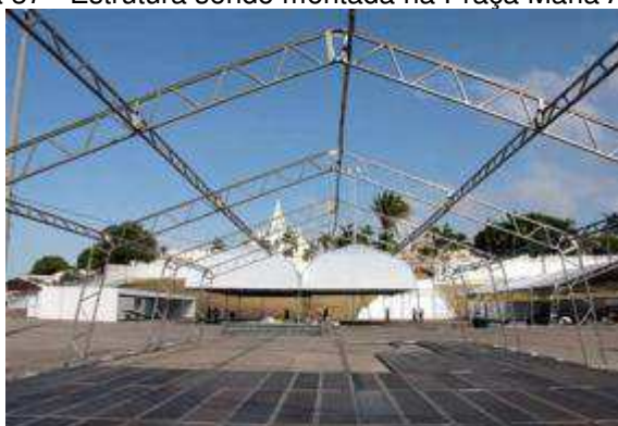
Figura 37 - Estrutura sendo montada na Praça Maria Aragão.
