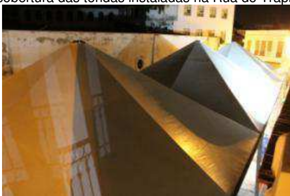
Figura 64 - Vista da cobertura das tendas instaladas na Rua do Trapiche para a 10ª FeliS.
