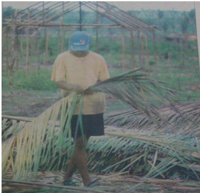
FIGURA 4 – Morador reconstruindo sua casa.
