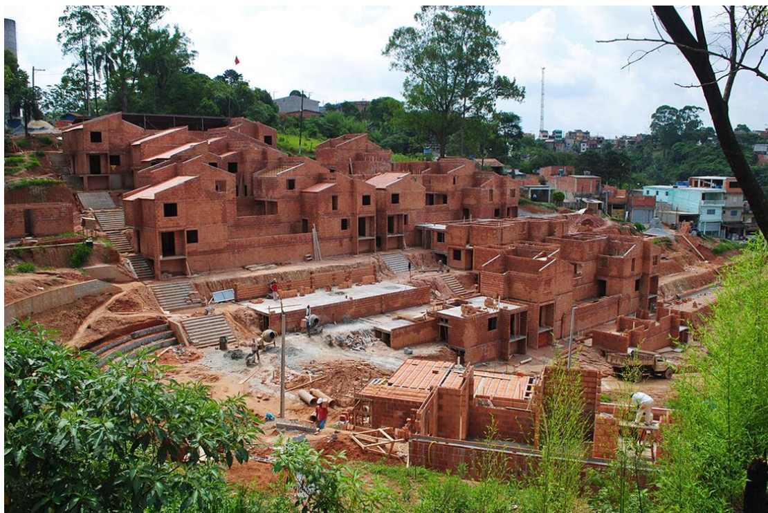
Figura 07 – Comuna Urbana Dom Hélder Câmara em construção
