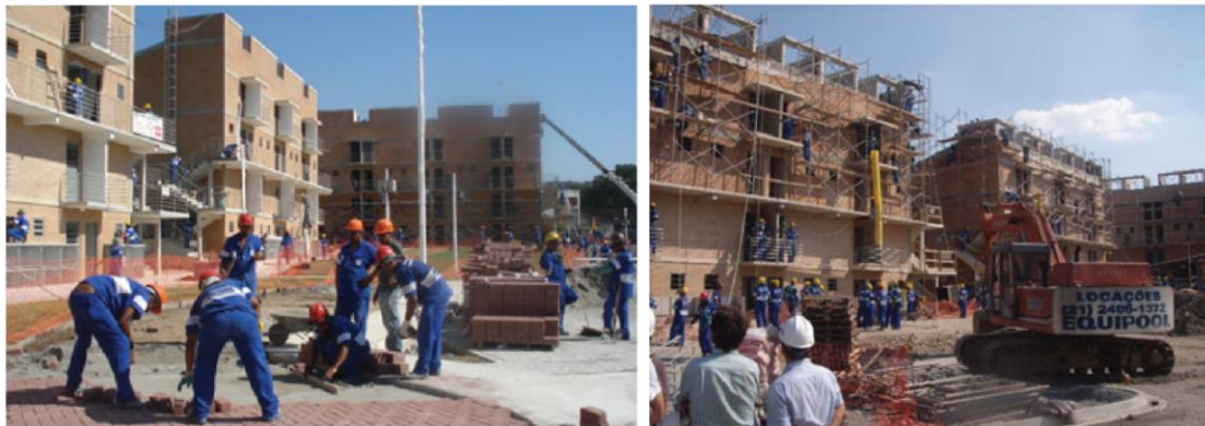
Figura 41 – Unidades Habitacionais do Complexo do Alemão em obras
