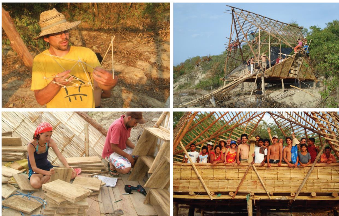
Figura 33 – Participação da comunidade na construção da Escola Nueva Esperanza
