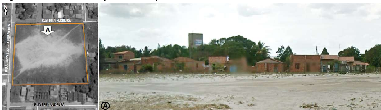
Figura 25: Vãos das edificações voltadas para o terreno
