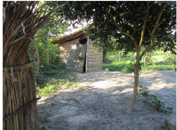
Figura 57: Sentina ao fundo feita de taipa de mão e coberta com telha cerâmica.
