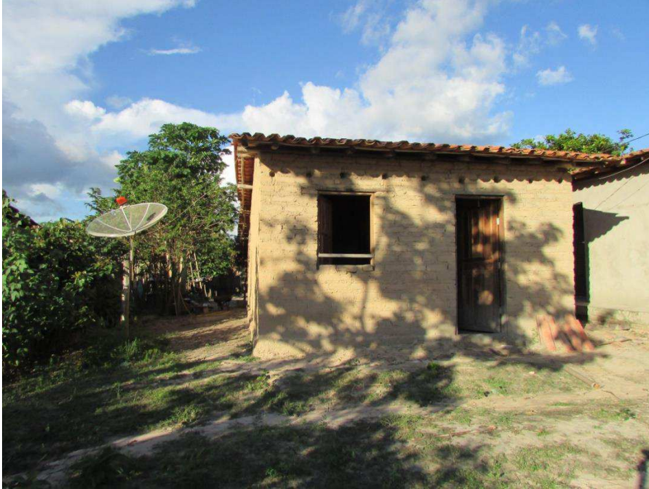
Figura 43: Casa da Dona Naidles, construção em adobe e coberta com telhas cerâmicas. Fonte: LATESE, 2017.
