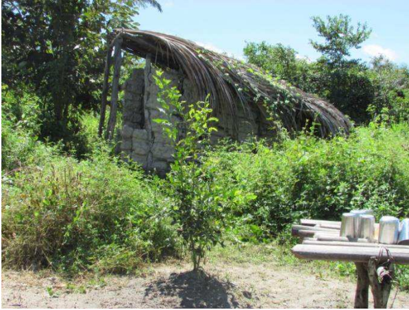
Figura 77: Sentina de taipa de mão e cobertura de palha ao fundo do lote. Fonte: LATESE, 2017.
