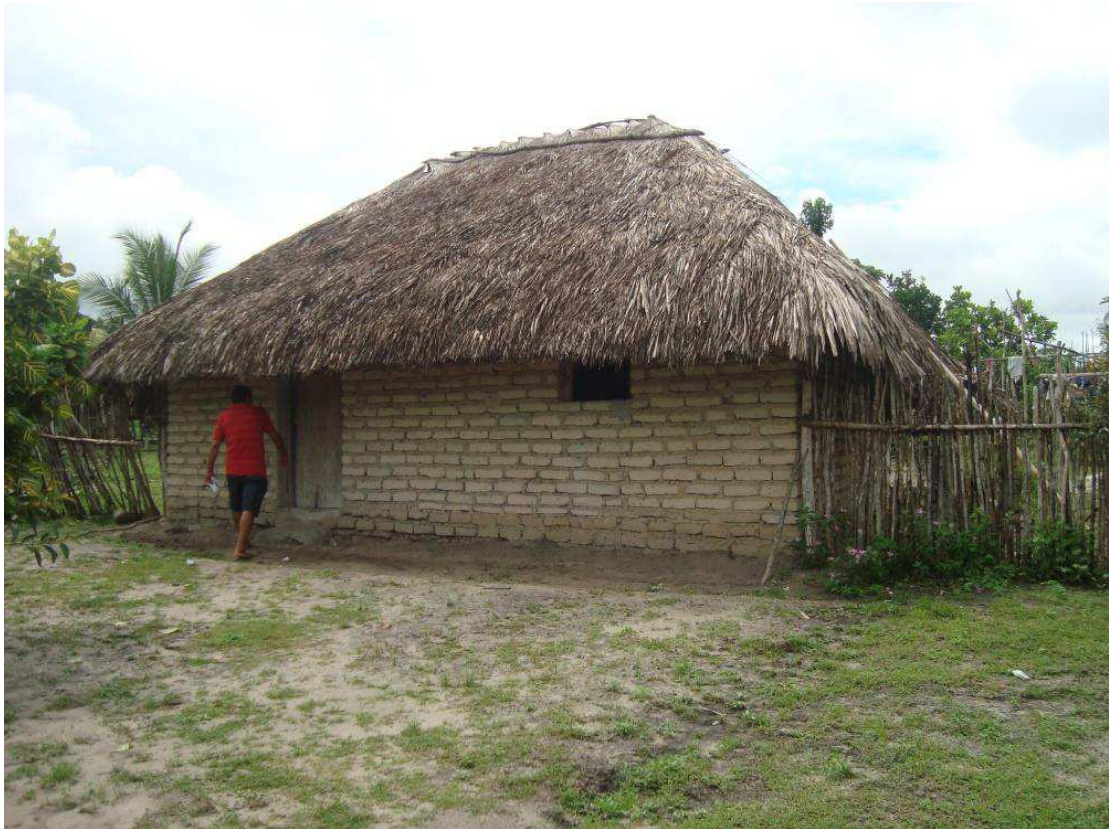
Figura 1: Casa de adobe com cobertura de palha, no Povoado de Pequizeiro, em Belágua, MA. Fonte: LATESE, 2016.
