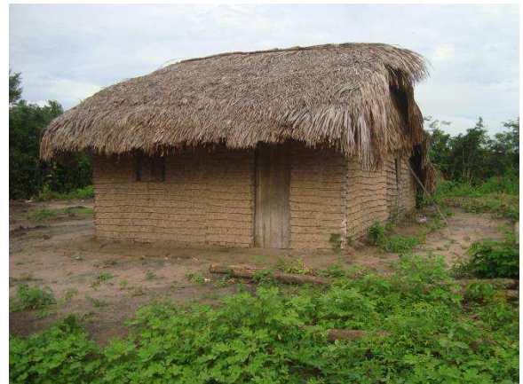
Figura 30: Casa de taipa de mão e cobertura de palha. Fonte: LATESE, 2016.
