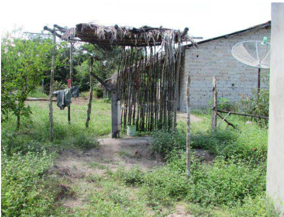
Figura 21: Poço manual, com estrutura de madeira coberta de palha. Fonte: LATESE, 2017.
