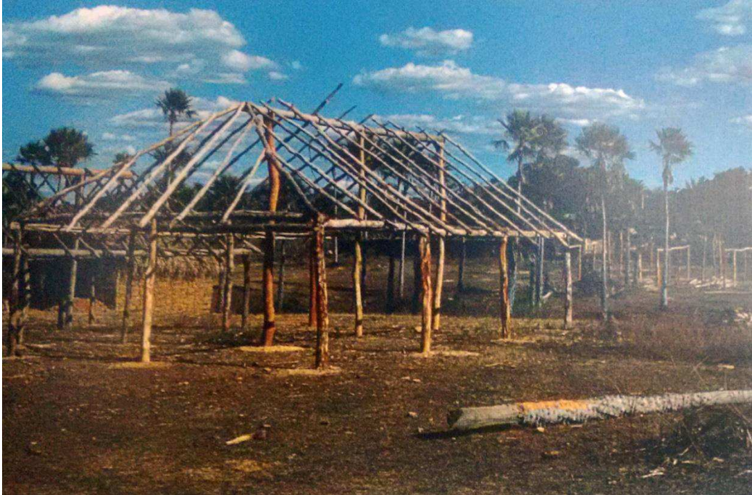
Figura 9: Armação estrutural de carnaúba para uma no campo, Piauí. Fonte: SILVA F., 2007.
