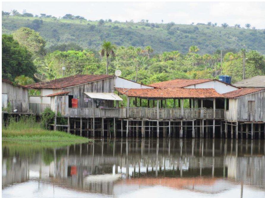
Figura 13: Casas de Madeira, em Buriticupu - MA. Fonte: LATESE, 2017
