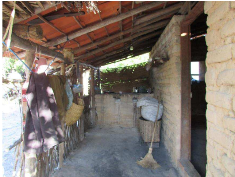
Figura 53: Meia-água que abriga o fogão a lenha, alguns utensílios e que tem ligação com o jirau. Fonte: LATESE, 2017.
