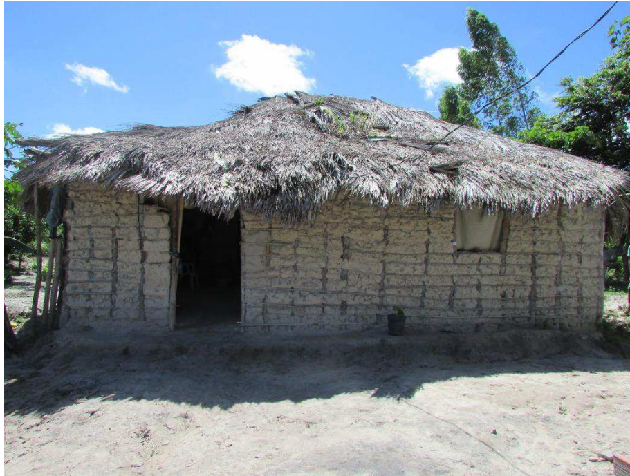
Figura 68: Casa da Dona Orizinha, feita em taipa de mão e coberta de palha. Fonte: LATESE, 2017.
