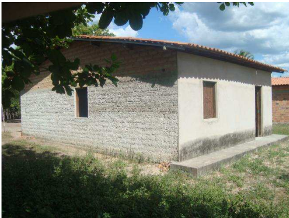
Figura 29: Casa de adobe, com fachada frontal revestida e cobertura com telha cerâmica. Fonte: LATESE, 2016.
