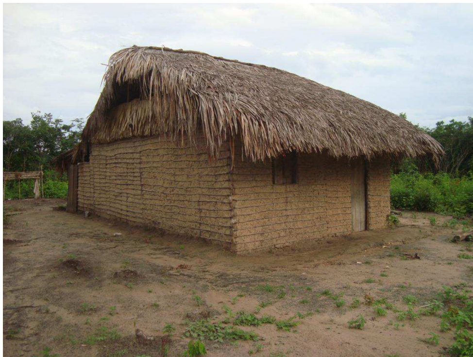
Figura 2: Casa de Taipa de Mão com cobertura de palha, no Povoado de Pequizeiro, em Belágua, MA.
