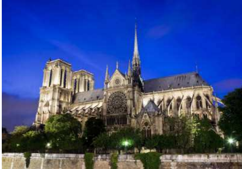
Figura 32 - Fachada da Catedral Gótica de Notre Dame, construída em 1163, Paris, França
