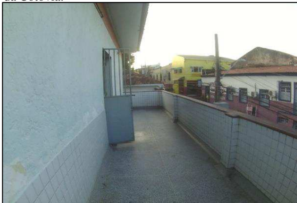
Figura 72 – Varanda do HMDM voltada para a Rua da Cotovia.
