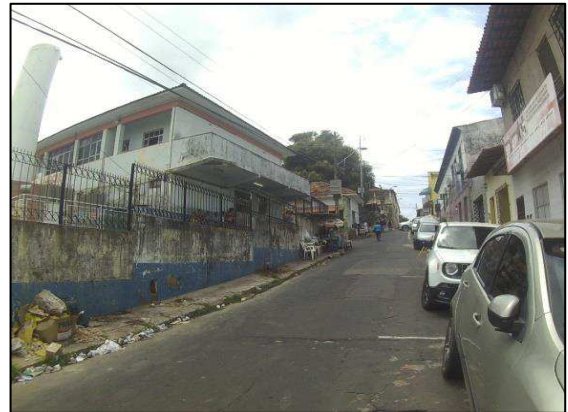
Figura 37 – Fachada voltada para a Rua da Cotovia, Hospital Djalma Marques.
