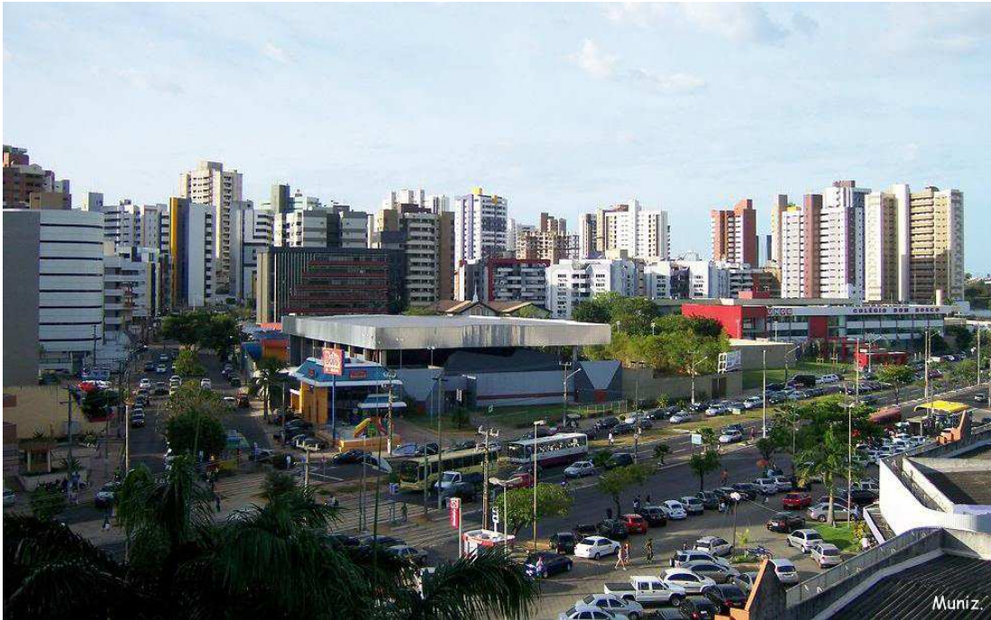
Figura 01 - Vista do Monumental Shopping, no bairro Renascença. Fonte: MUNIZ, 2007.
