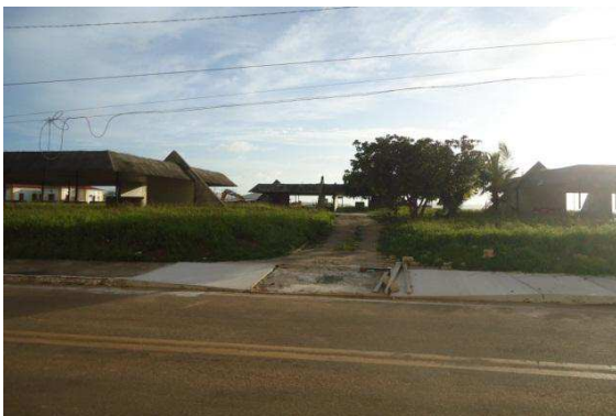
Figura 43 - Vista do acesso principal ao Memorial Bandeira Tribuzi. Fonte: CUNHA, 2014.
