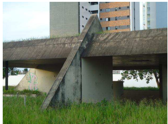
Figura 50 - Detalhe do pilar estrutural de um dos volumes do Memorial Bandeira Tribuzi. Fonte: CUNHA, 2014.
