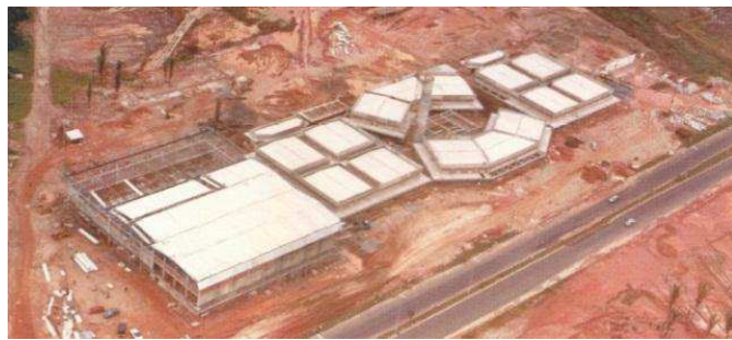
Figura 07 - Vista aérea da construção do Tropical Shopping Center. Fonte: CARVALHO, 2003.
