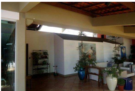
Figura 24 - Parte da residência Roosevelt Murad que sofreu ampliação 1. Fonte: CUNHA, 2014.
