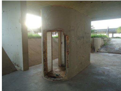
Figura 54 - Detalhe 2 do banheiro de um dos volumes do Memorial Bandeira Tribuzi. Fonte: CUNHA, 2014.
