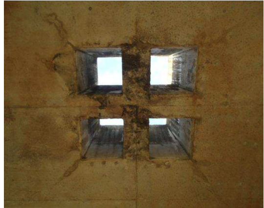
Figura 52 - Detalhe de abertura central para exaustão no teto de um dos volumes do Memorial Bandeira Tribuzi. Fonte: CUNHA, 2014.
