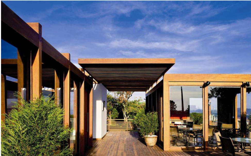
Figura 27 – Pergolado em madeira ligando os dois blocos
