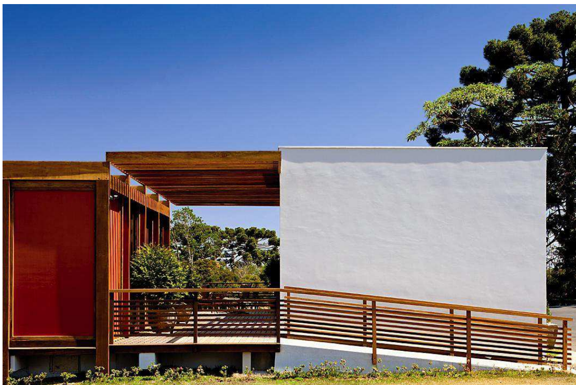
Figura 29 – Bloco opaco branco com acesso por rampa
