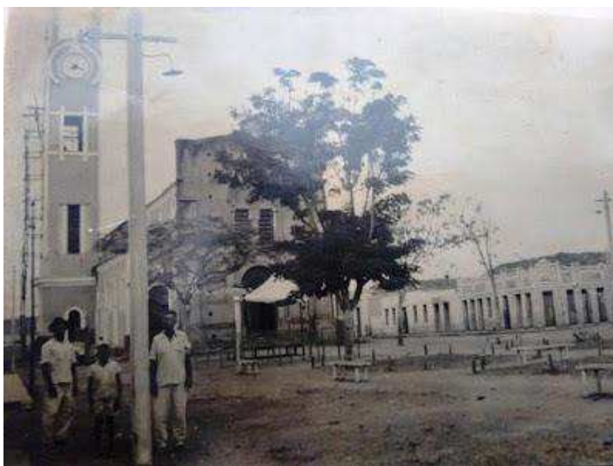
Figura 35: A igreja em fase final de construção. (Fonte: FOLHAS AVULSAS, 2015).
