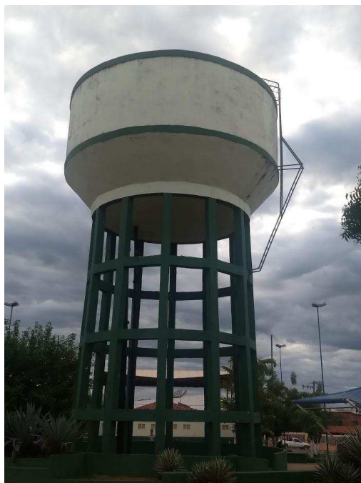
Figura 49: A caixa d'água da Praça São Sebastião hoje. (Fonte: ARQUIVO PESSOAL, 2019).
