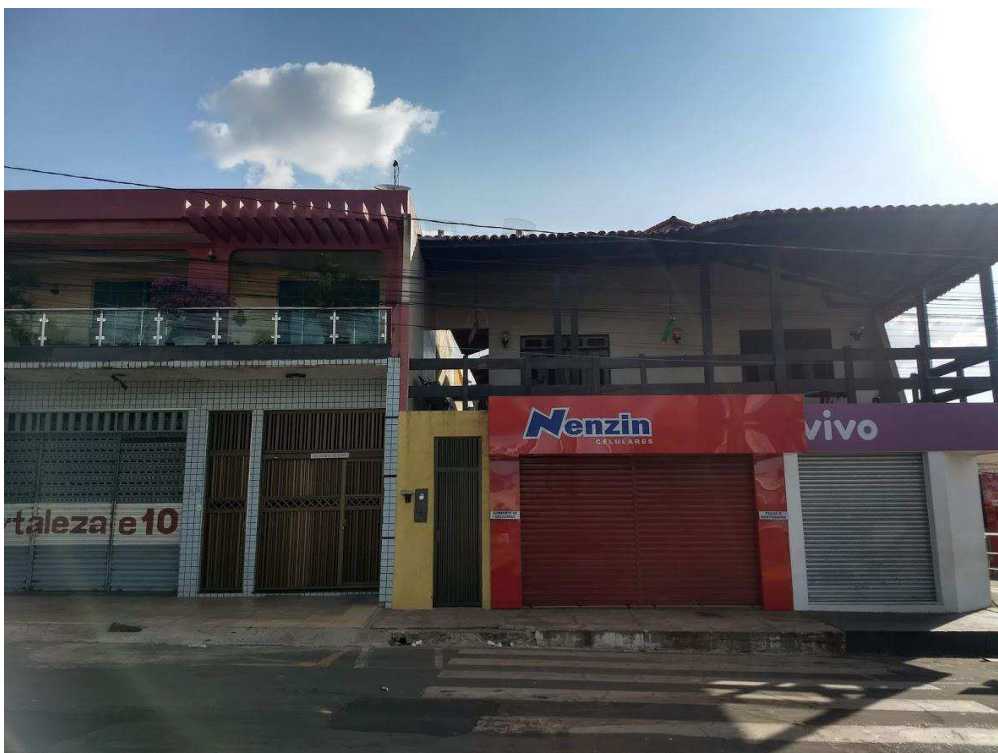
Figura 53: Residências em cima de lojas, outra tipologia comumente encontrada na praça. (Fonte: ARQUIVO PESSOAL, 2019).
