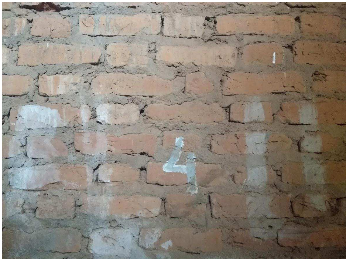
Figura 43: Uma Parede de adobe sem reboco mostra a técnica construtiva utilizada na construção da Igreja Matriz. (Fonte: ARQUIVO PESSOAL, 2019).
