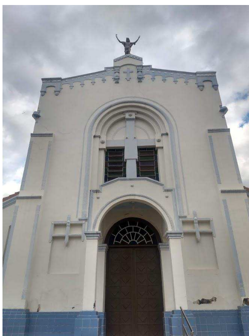
Figura 38: Fachada principal. É possível ver a faixa de revestimento cerâmico instalada na última reforma. (Fonte: ARQUIVO PESSOAL, 2019).
