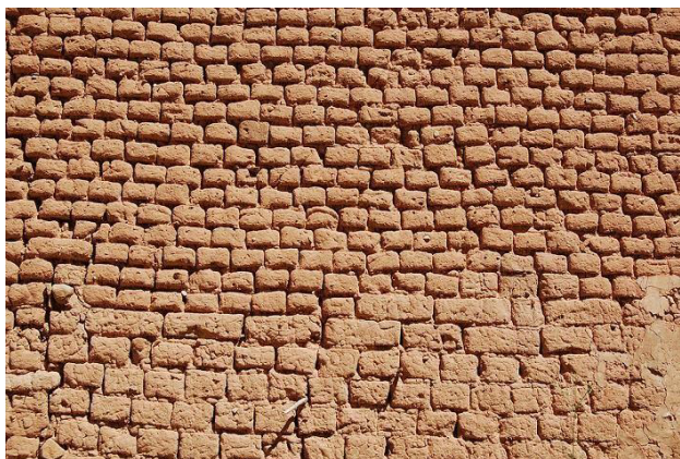
Figura 23: Muro com tijolos de adobe, também chamado de “tijolo cru”, é um bloco de argila secada ao sol e muitas vezes misturada com palha para aumentar a resistência. Até hoje, é uma técnica construtiva presente na região. (Fonte: BRASIL ACADÊMICO, 2010).
