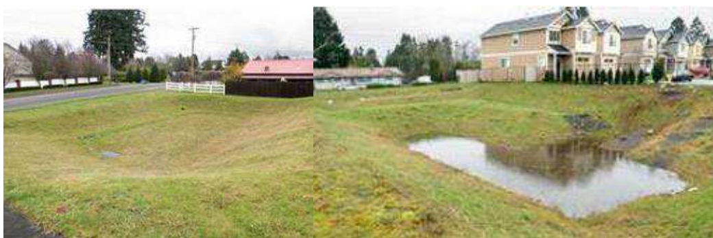
Figura 12 - Exemplo de Bacia de Infiltração antes e após a chuva.
