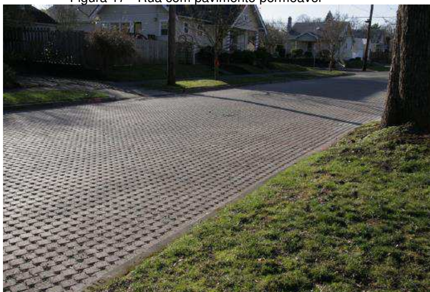
Figura 17 - Rua com pavimento permeável
