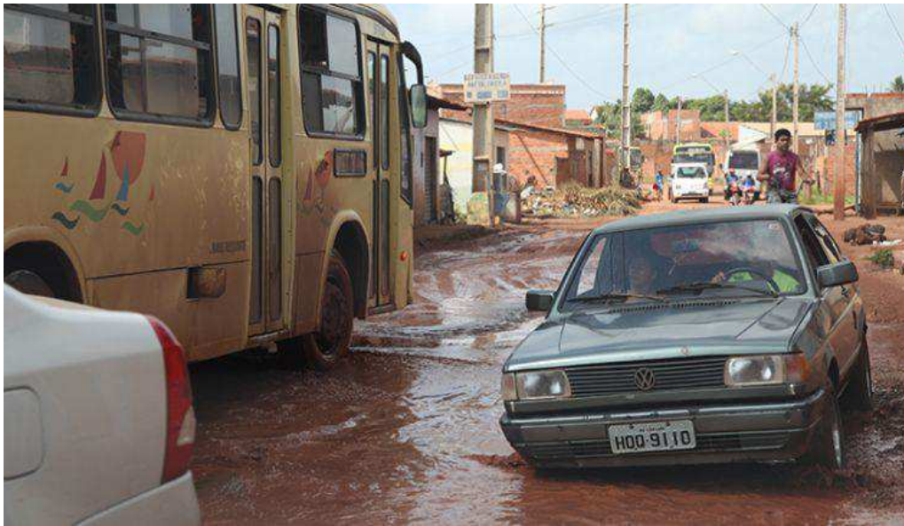
Figura 12 – Bairro do Geniparana: Ruas sem asfaltamento. https://oestadoma.com/noticias/2016/07/23 (Último acesso 25/10/2019)
