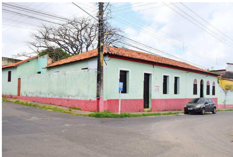
Figura 22 – Fachada Casa das Minas
