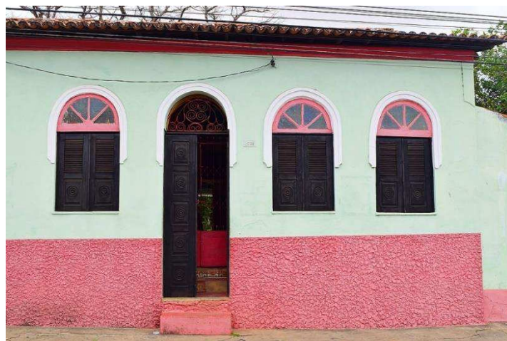
Figura 24 – Fachada 2 Casa das Minas
