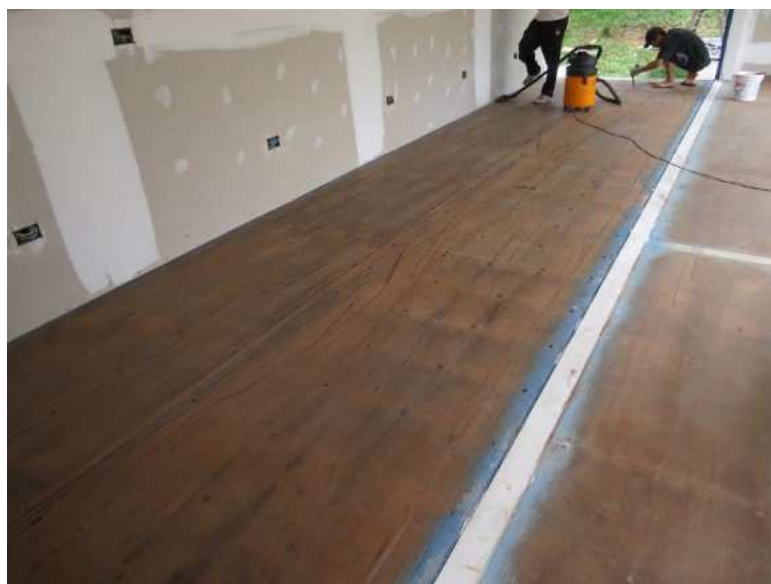
Figura 50 – Lixamento do compensado naval do próprio contêiner
