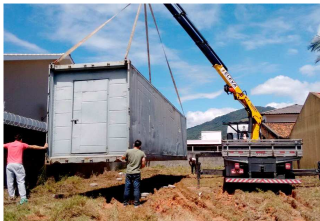
Figura 47 – Caminhão Munck içando contêiner
