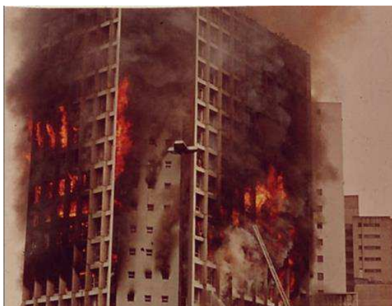
Figura 04: Edifício Joelma em Chamas 4
