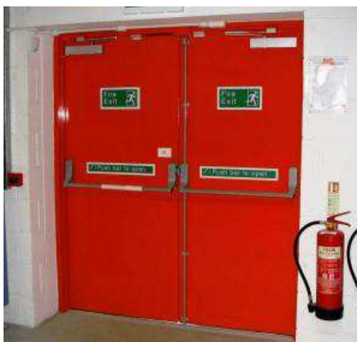
Figura 09: Exemplo de porta corta-fogo de duas folhas 7
