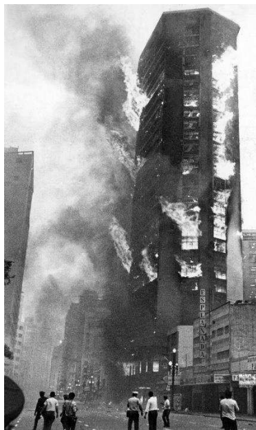
Figura 03: Edifício Andraus em chamas 3
