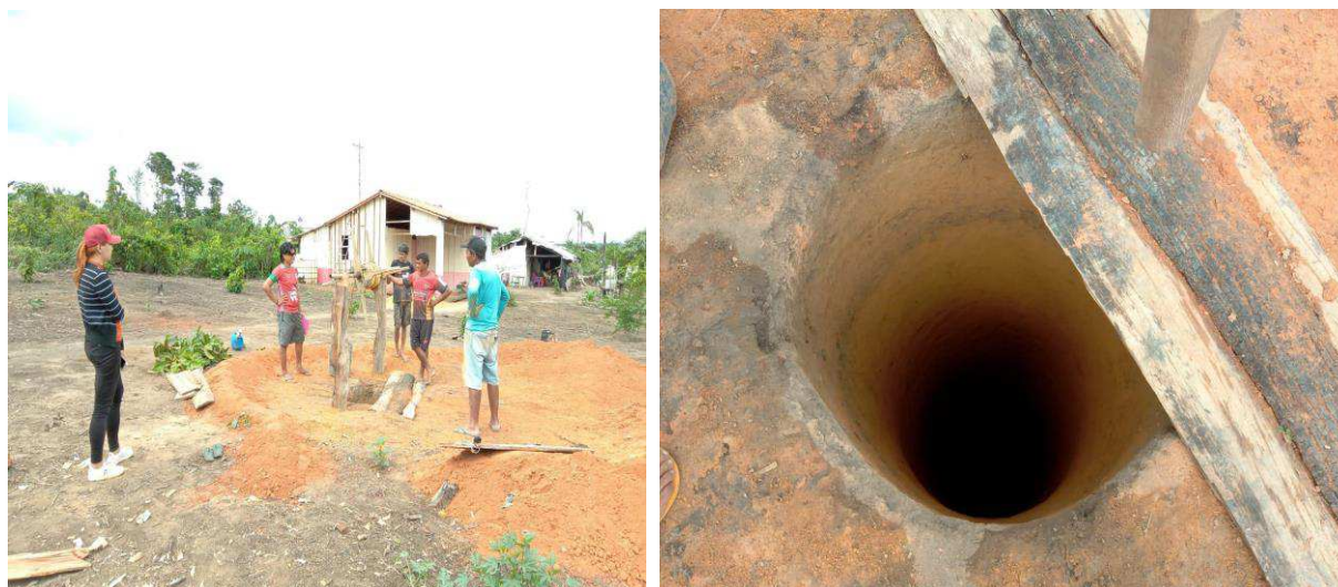
Figura 11 e 12: Perfuração do poço no acampamento
