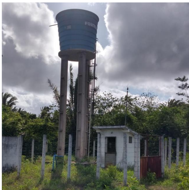
Imagem 33 - SSAA construído na comunidade Fazenda.
