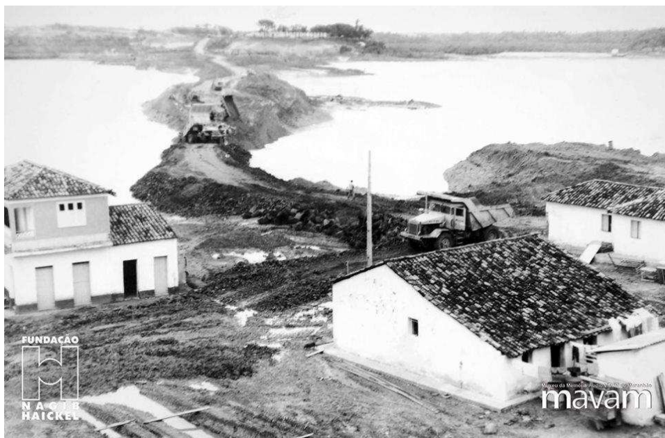
Figura 18 - Construção da Barragem do Bacanga entre os anos 1960-1970.
