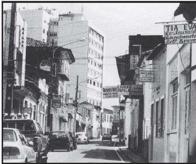
Figura 20 - Edifício Caiçara vista pela Rua São Pantaleão (2001).
