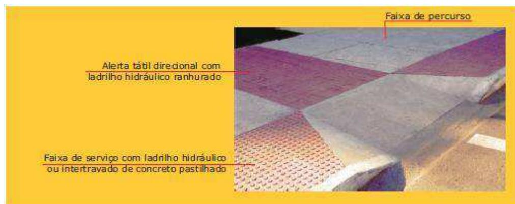
**Figura 49: Tipos de revestimentos para as faixas nas calçadas**
