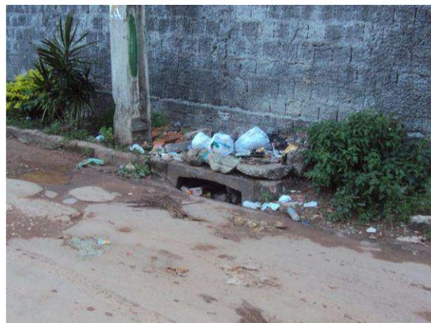
**Figura 61: Lixo sobre calçada obstruindo ponto de drenagem de água.**
