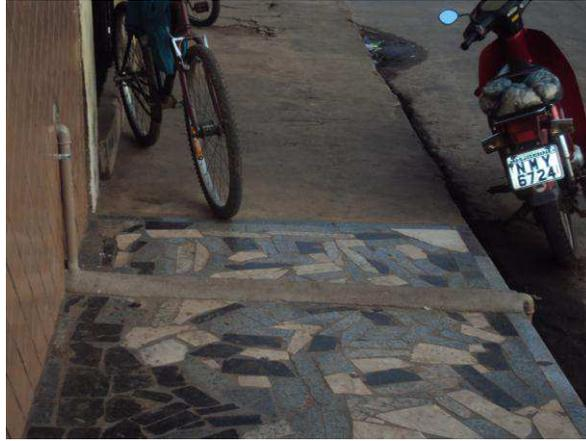
**Figura 85: Tubulação construída sobre calçada**
