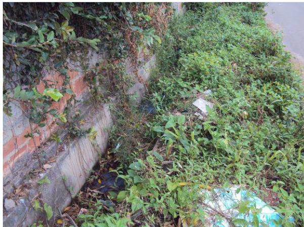
**Figura 63: Área da calçada com esgoto a céu aberto, lixo e vegetação cobrindo parte da via**
