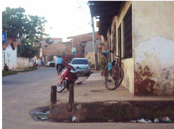
**Figura 84: Calçada alta impede acesso de pessoas com mobilidade reduzida**
