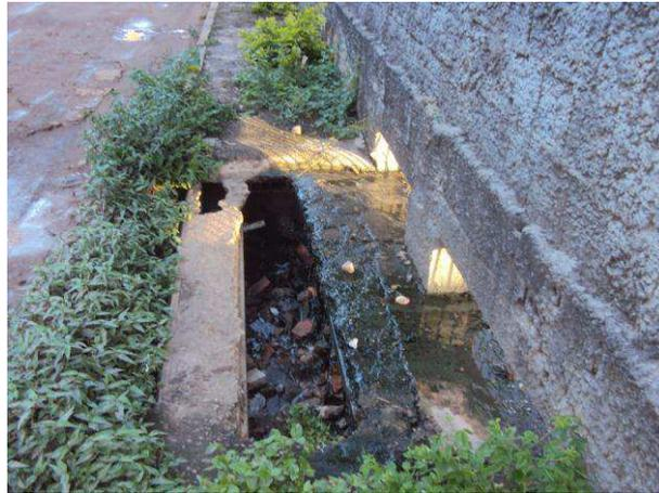
**Figura 60: Água escorrendo sobre a calçada deteriorando a pavimentação**
